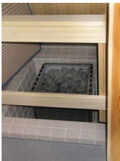
Kuva 6. Kivas on upotettu lattiaan.
