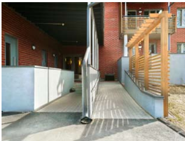
Kuva 7. Sisäänkäynnin luiska on liian jyrkkä. Luiskan päällä ei ole katosta, joten lumi sataa suoraan luiskalle.
