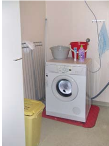
Kuva 3. Kylpyhuoneessa on pesukoneliitäntä.
