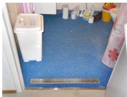
Kuva 2. Pesuhuoneissa on kynnyškaivot ja kitkalattiat.
