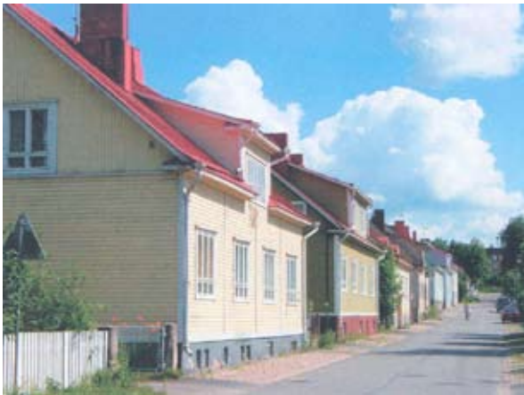
Lahden Paavolassa yhteisestä liikkumistilasta on erotettu luonnonkivipinnoitteella viitteellisesti pysäköintialue.
