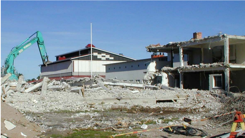
Kuva 27. Lajittelevaa purkua Puolangan kirkonkylän koulun purkutyömaalla. Kuva Unto Ritvanen.
