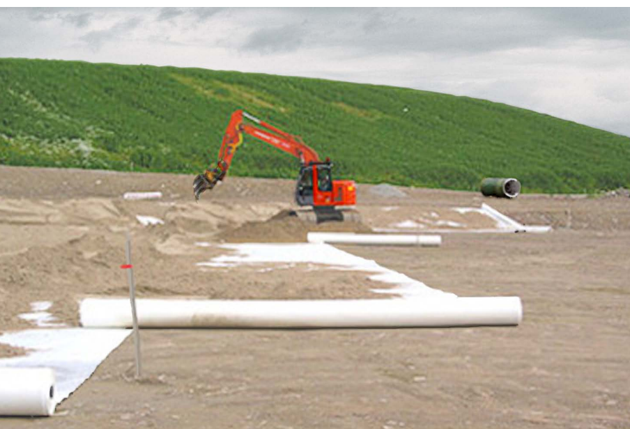
Kuva 8. Majasaarenkankaan jätekeskuksessa rakennetaan uutta jätteiden täyttöaluetta. Takana näkyy maisemoitu täyttöalue. Kuva Unto Ritvanen.
