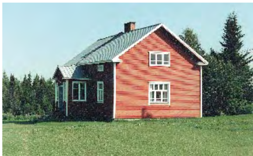
Kuvat 32–33. Hyvin jälleenrakennuskauden tyyliinsä säilyttäneet Ylitalo ja Hyötylä. Kuvat Kari Tallavaara.
