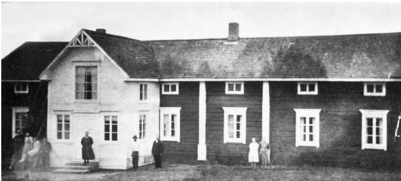
Kuva 29. Sodassa tuhoutunut vanha Tallavaaran päärakennus, jonka eteläpuoleinen pirttipää oli rakennettuna jo ennen 1800-luvun puoltaväliä. Taloa jatkettiin salipäällä 1880-luvulla, jolloin myös rakennettiin ensimmäinen, vaatimattomampi kuisti. Uusi, korkeampi kuisti pystytettiin 1920-luvulla. Kuva Kairalan Kyläseuran kokoelmat.
