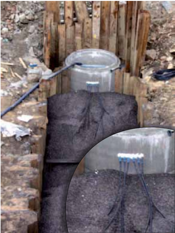
Kuva 33. Näytteenotto-putket rautatäytteestä kaivoon (PIR).
