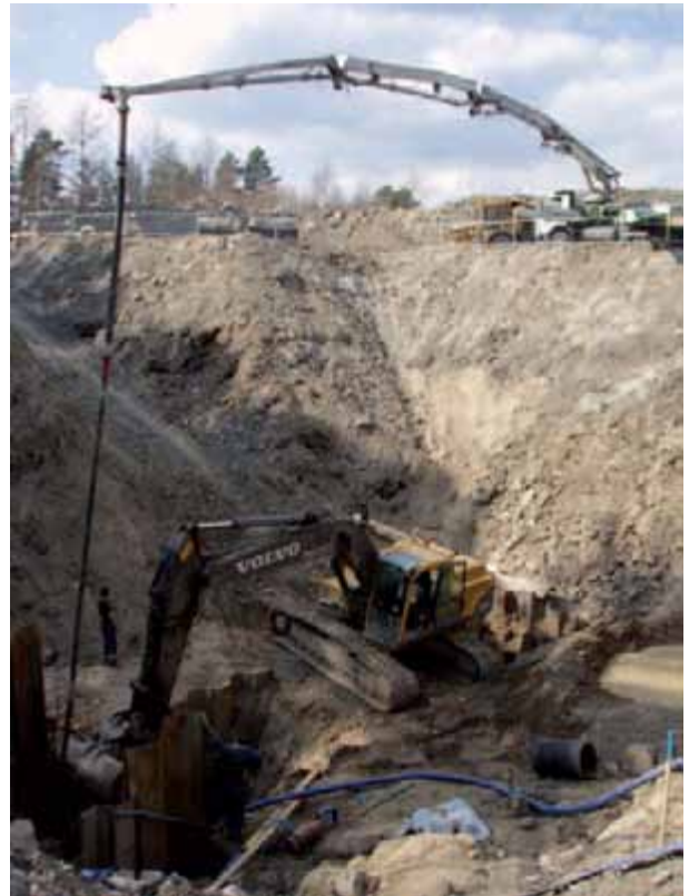
Kuva 31. Kallioperän injektointi (PIR).
