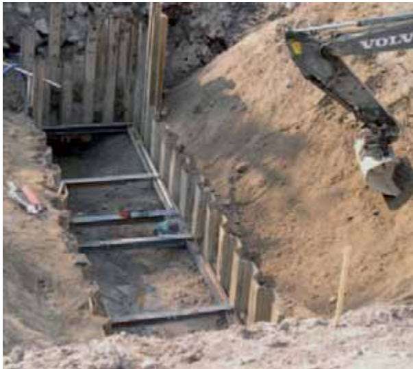
Kuva 30. Tuettu kaivanto (Suomen ympäristökeskus).
