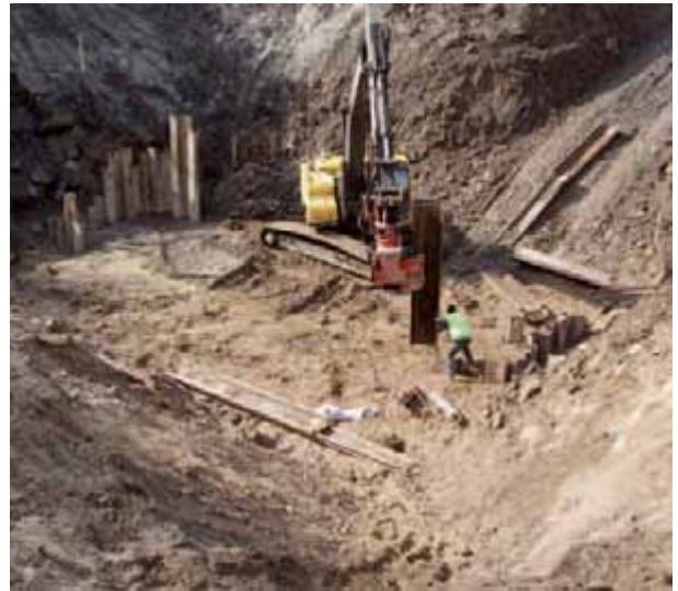
Kuva 29. Ponttiseinien tekoa (PIR).
