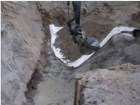
Kuva 34. Itäisen ohjauseinän tekoa (PIR).
