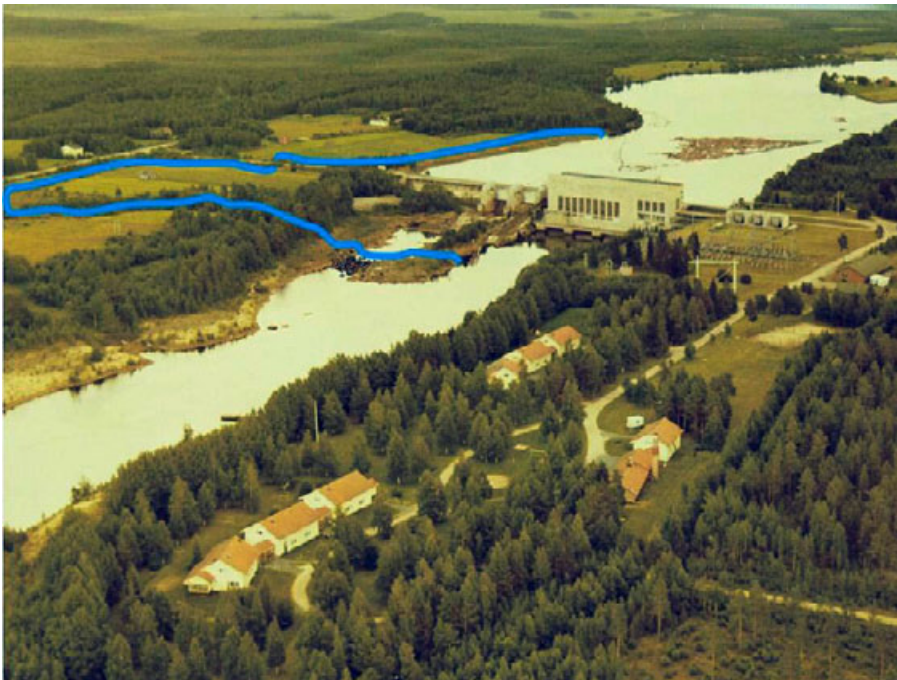
Kuva 21. Pällin voimalaitoksen ohitusuoman linjaus tulvauoman, luonnonpuron ja peltoalueiden kautta. Kuvaan on piirretty myös suunniteltu pohjapato. Kuva: Fortumin arkisto
