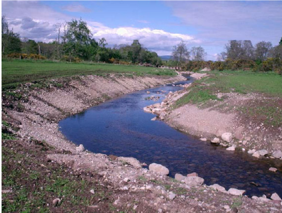
Kuva 10. Conon -joen saareen kaivetun Dunglass –poikastuotantouoman uutta osuutta Skotlan- nissa, rakennettu 2004 - 2007. Uoman leveys on noin 5 m, keskilaltevuus 0,33 % ja minimivirtaama 0,5 m 3 /s. Koekalastuksessa vuonna 2006 saatiin saman vuoden (0+) Atlantin lohen poikasia 160 ja kesän vanhoja (1+) 70 kpl/100m 2 . Uoman tuloksia voidaan hyödyntää ohitusuomien suunnittelussa Suomessa. Kuva: Simon McKelvey
