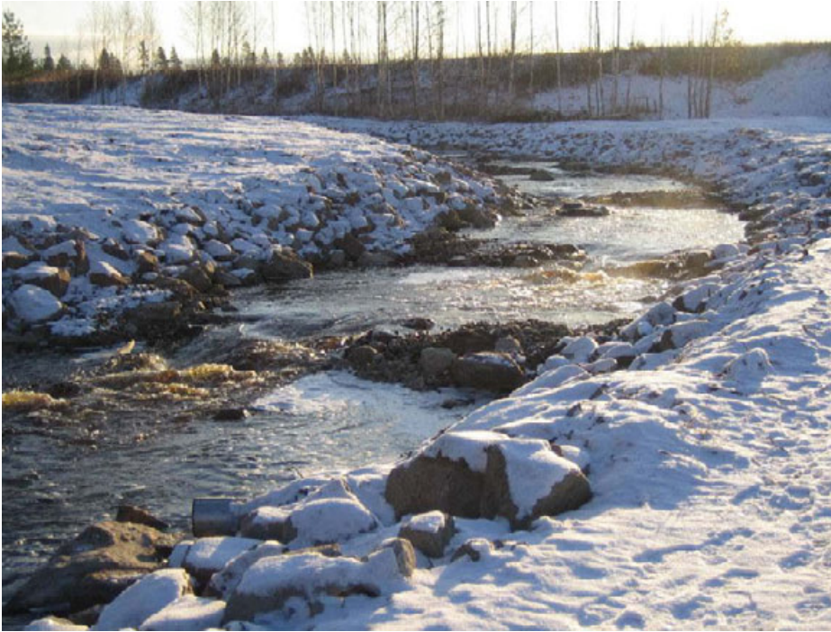
Kuva 3. Perhojokeen rakennetun Kaitforsin Sääkskosken kalatien porrastunutta koskea vastaavaa osuutta, jossa kynnysten väliin jää syvänteitä, talvivirtaamalla 0,5 m 3 /s. Istutettujen lohien poikasten on havaittu elävän uomassa. Kuva: Jukka Jormola
