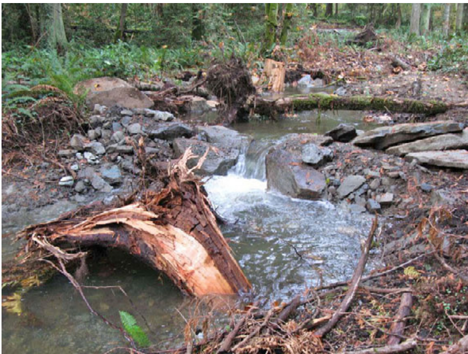
Kuva 9. Millstone -joen ohitusuoma Nanaimossa, Vancouver Island, Kanada. Rakennettu 2007 Bowen Park -puistoon vesiputouksen ohittavaksi kalatieksi ja samalla Tyynenmeren lohien poikastuotantouomaksi. Juurakkoja ja runkoja on aseteltu suojaksi poikasille. Kuva: Jukka Jormola
