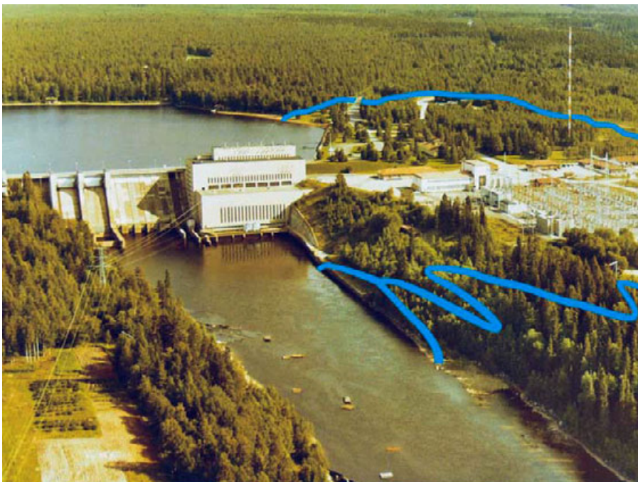
Kuva 18. Havainnekuva Pyhäkosken ohitusuoman linjauksesta. Uoma mutkittelee rinteessä osittain pengerrettyinä. Vaihtoehtoisista suuaukon sijainneista ylempi sijoittuu lähelle voimalaitosta ranta- muurin juureen. Pääuoman suuria virrannopeuksia tulisi hillitä suuaukon yläpuolelle tehtävällä lyhyellä suisteella ja pyörteitä aiheuttavilla rantakivillä. Optimaalista suuaukon sijainti olisi selvitettävä kalatutkimuksin. Kuva: Fortumin arkisto
