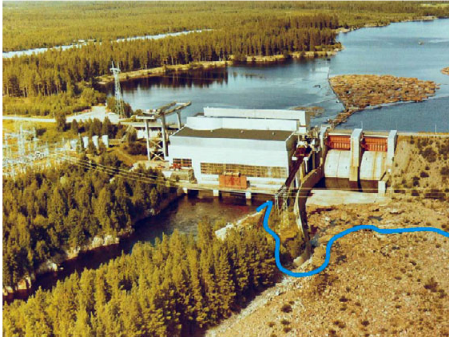
Kuva 28. Ohitusuomalle tehdään reitti tulvauoman poikki siinä olevien altaiden kautta hiukan kalliota louhien. Ohitusuoma kulkisi tulvauoman suojamuurin ja vanhan tervareitin veneenvetomöjlän välistä. Kuva: Fortumin arkisto
