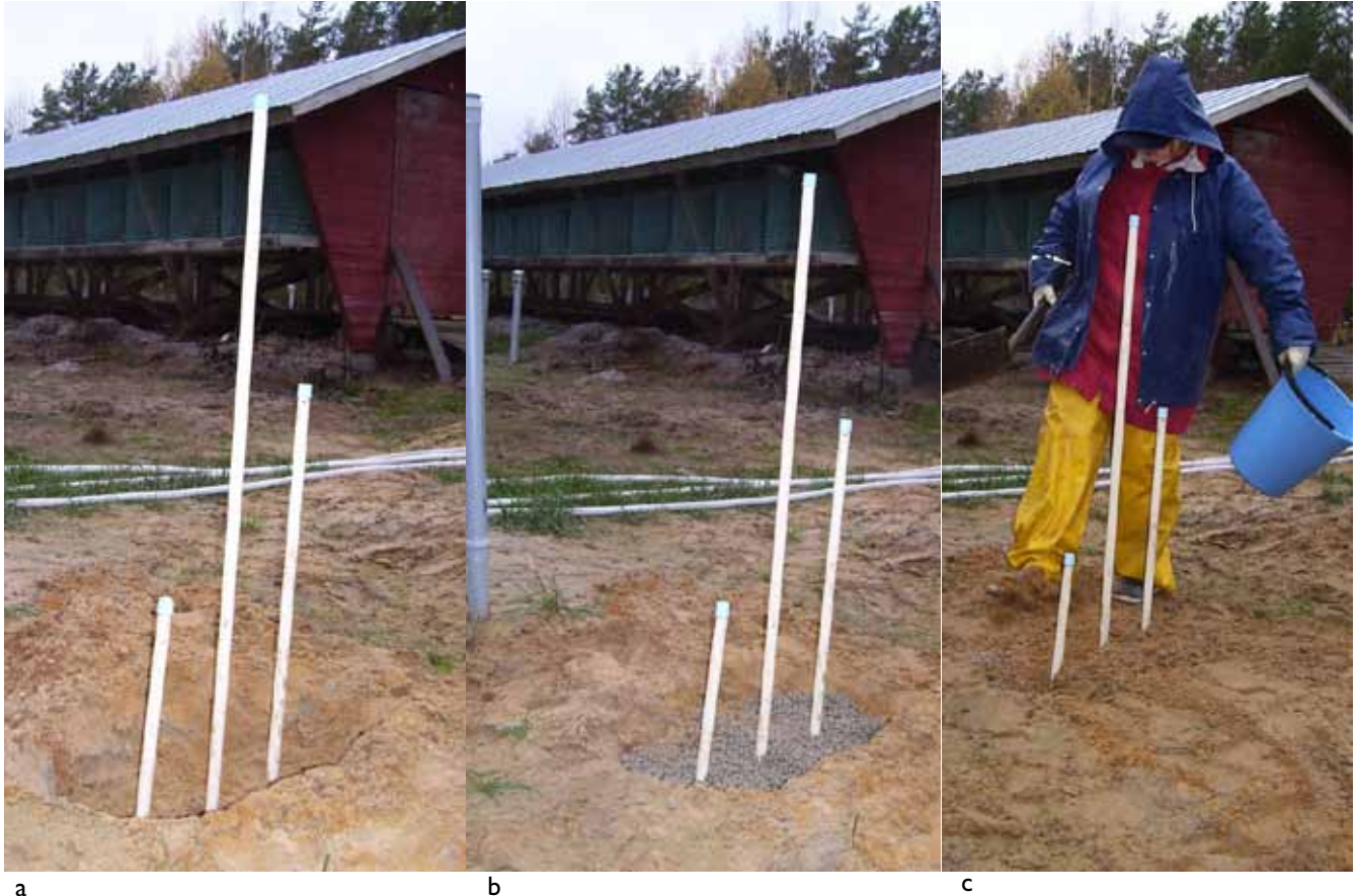
Tiiviin kannen teko huokoskaasuputkille PG6A, PG6B ja PG6C: a) pintamaata poistettu huokoskaasuputkien ympäriltä, b) bentoniittipellettitäyttö, c) tiivistys kastelun jälkeen. (Kuvat: Sanna Petäjäjärvi)
