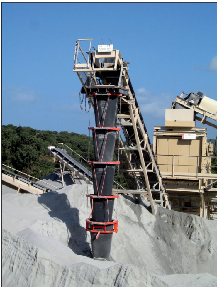
Kuva 10. Teleskooppiputki materiaalin puto- tuskohdassa. (Kuva Sandvik 2010)
