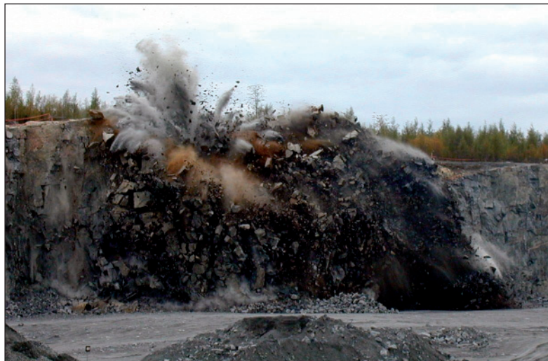
Kuva 7. Pengerlouhinta on tavantoinen kalliomaisten kallioiden räjätystyötapo. (Kuva Infra ry 2010)
