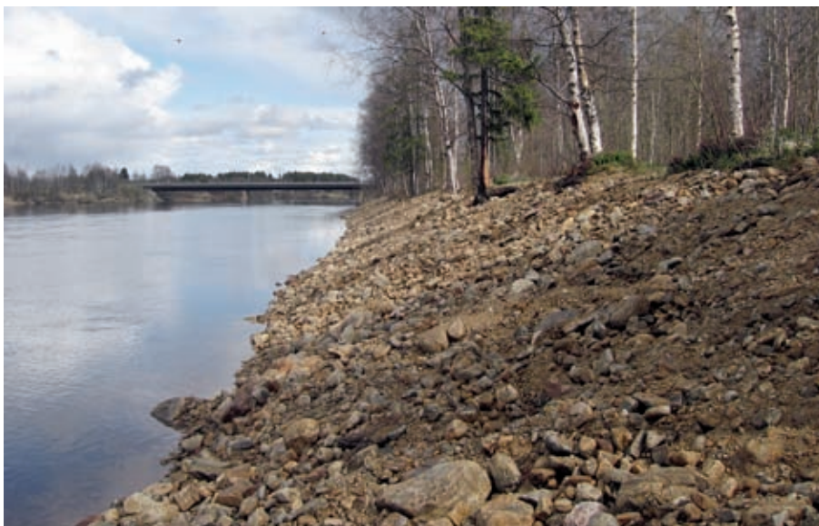
Ivalojoen Tullinranta rantasuojauksen jälkeen (kuva Tuomo Salakka).
