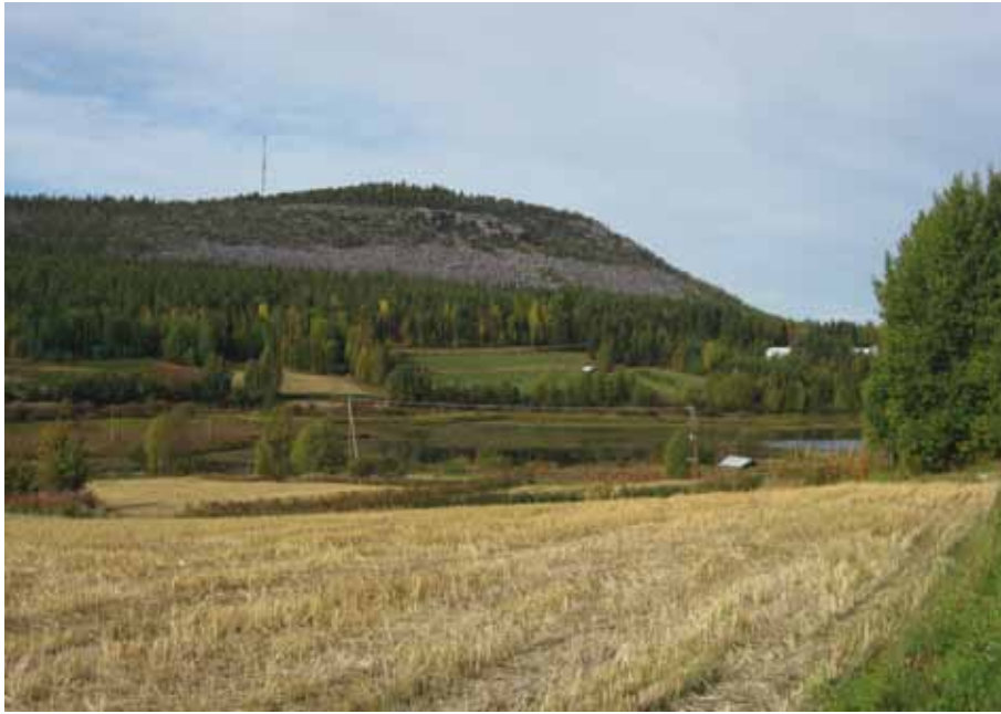
Kuva 95. Aavasaksan (TUU-13-154) kalottivaara kaakosta nähtynä. Radiomasto sijaitsee moreenikalotin alaosassa. Vaaran itärinteeseen jyrkänne on aallokon paljaaksi huuhtoma ja siitä irronneet lohkarieet ovat kerrostuneet jyrkänneen alaosaan. Kuva: K. Mäkinen, GTK.
