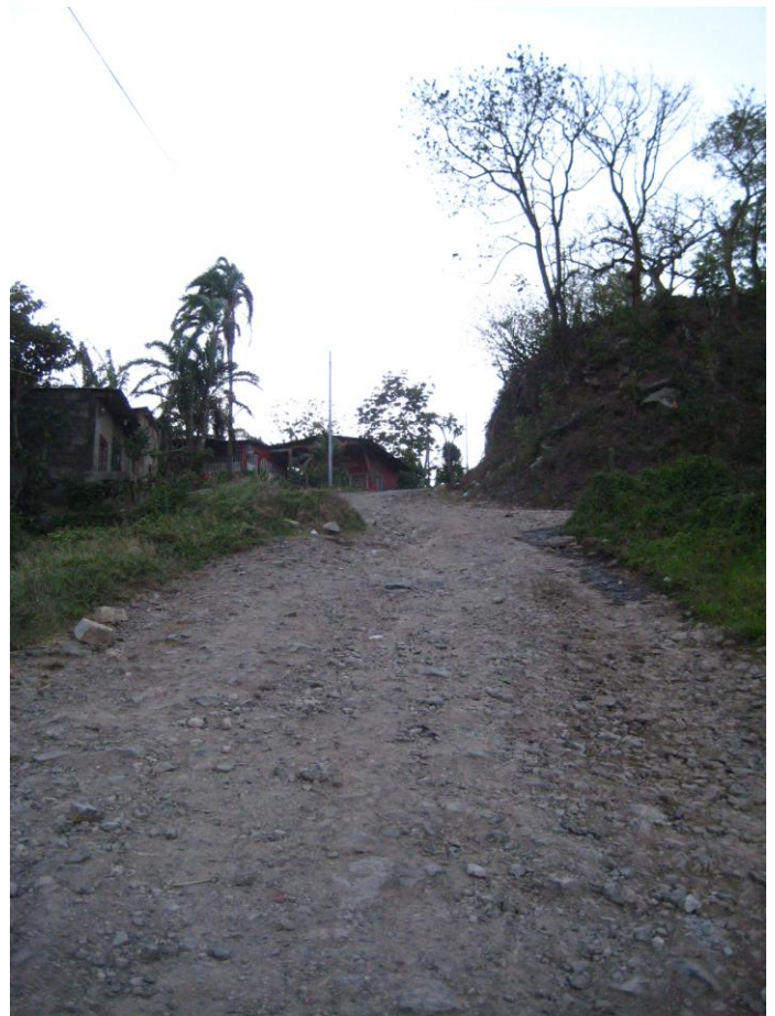
Kuva 18. Tiet eivät ole Chontalesissa kovin hyvässä kunnossa. Etenkin päätieltä kauaksi poikkeavia teitä ei pidetä kunnossa. Tie on keskellä korkeampi, jotta vesi valuisi tien reunoille.
