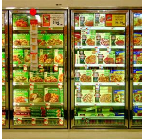
Kuva 12. Oikealla loisteputkivalaistu ja vasemmalla LED-valaistu pakkaskaappi (Cimo, 2007)
