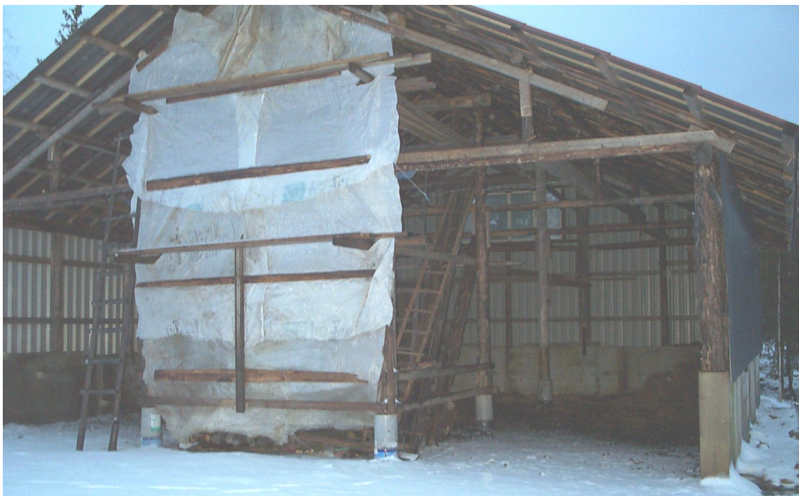
Kuva 10. Toimiva säätasuojat. Säätasuojan seinien alaosat ovat betonia, mikä helpottaa koneellista kestokuivikepohjan tyhjentämistä. Säätasuojan kattoristikoiden päädyt sulkeminen lisäisi suojaavuutta.
