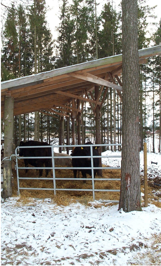
Kuva 6. Edullinen säänsuoja. Kuva ei ole ylämaankarjan pitopaikasta, mutta on mukana esimerkkinä edullisesta rakentamisesta. Takaseinä ja ainakin toinen päätyseinä lisäisivät suojaavuutta tuulta vastaan.
