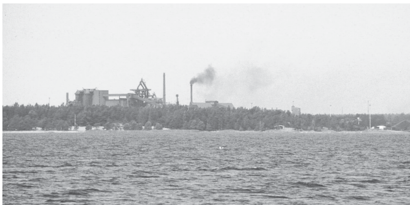
Järn- och stålverket i Koverhar har alltsedan sin tillblivelse haft en dominerande ställning i närmiljön. Masugnen, som är en av de minsta i Europa, blev färdig 1961. Den har förblivit konkurrenskraftig tack vare innovationer i processtekniken (foto Martin Lodenius).
