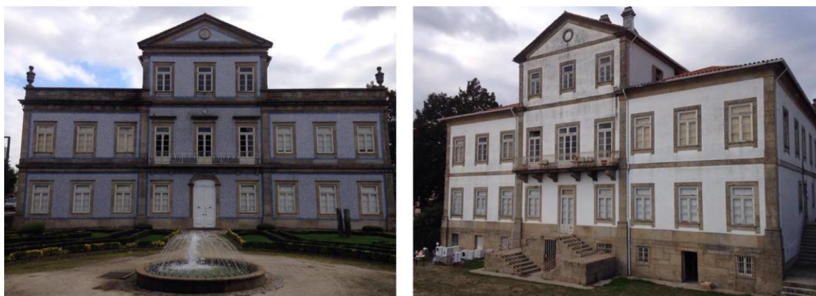
Figura 13: Da esquerda para direita: Fachada frontal da Casa da Cultura. Fachada posterior da Casa Cultura. Foto de autor: Ana Carneiro
