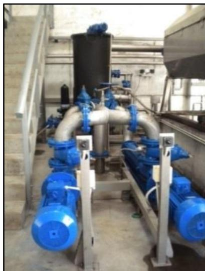
**Figura 4.7** – Injeção de polímero no floculador instalado na ETAR de Água Longa.
