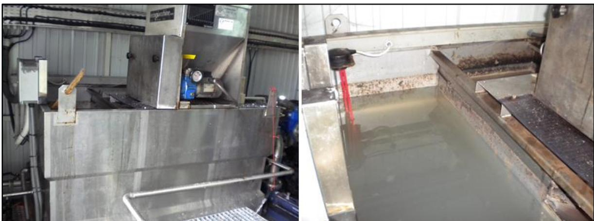
**Figura 4.4** – Modelo da unidade de preparação de polímero instalada na ETAR de Esposende.
