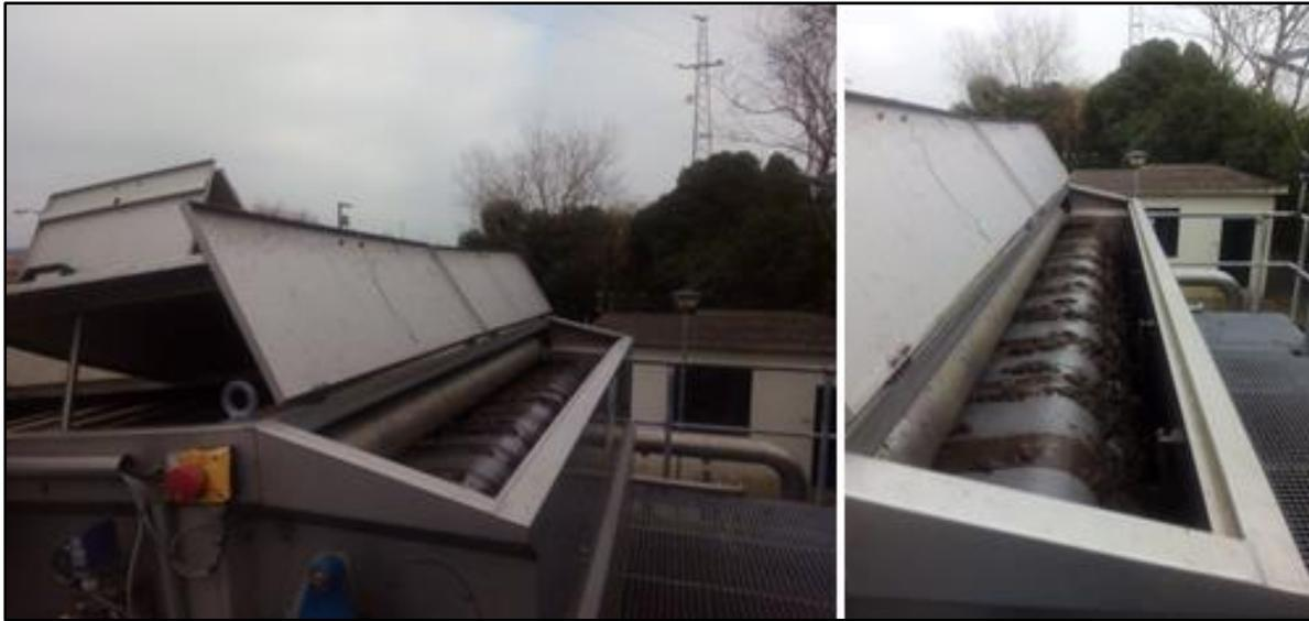
**Figura 4.3** – Mesa de espessamento *OMEGA 25 SD* instalada na ETAR de Esposende.
