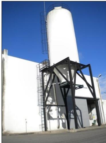
**Figura 2.4** – Silo de armazenamento de lamas de depuração de ETAR (Fonte: ETAR de Água Longa).
