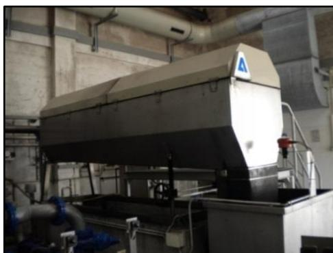
**Figura 4.9** – Tambor rotativo de espessamento *Andritz* instalado na ETAR de Água Longa.
