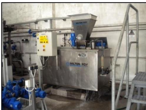
**Figura 4.8** – Modelo da unidade de preparação de polímero instalado na ETAR de Água Longa.
