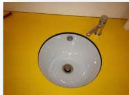
Figura 13. Lavatório da sala 2
