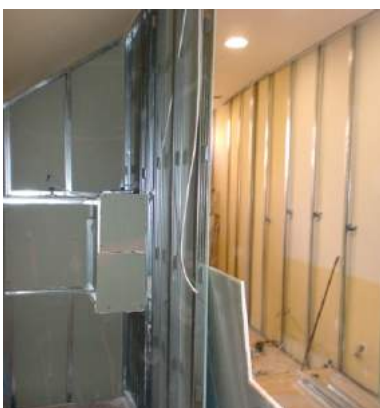
figura 26 - Aplicação de gesso cartonado
