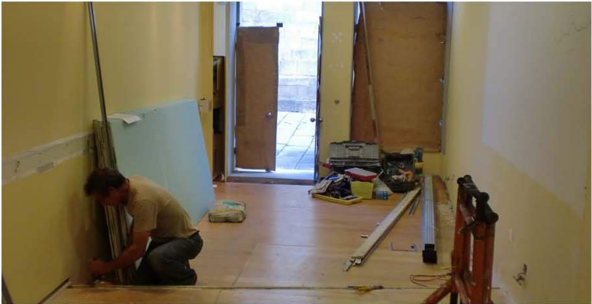
. Execução de obras no interior da loja
