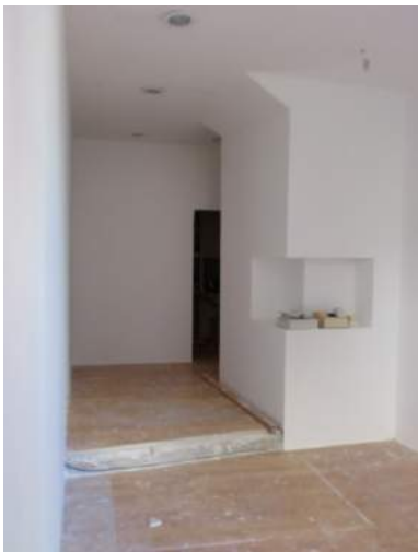
figura 29 - Aperfeiçoamento das paredes
