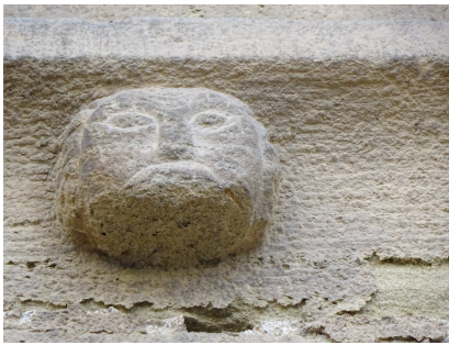
Figura 20: Detalle de canecillo del dintel de la portada del monasterio © Araceli Rosillo,
