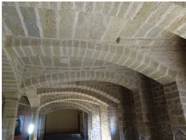
Figura 24: Detalle de los arcos transversales y longitudinales de la sala gótica © Araceli Rosillo, 2016.
