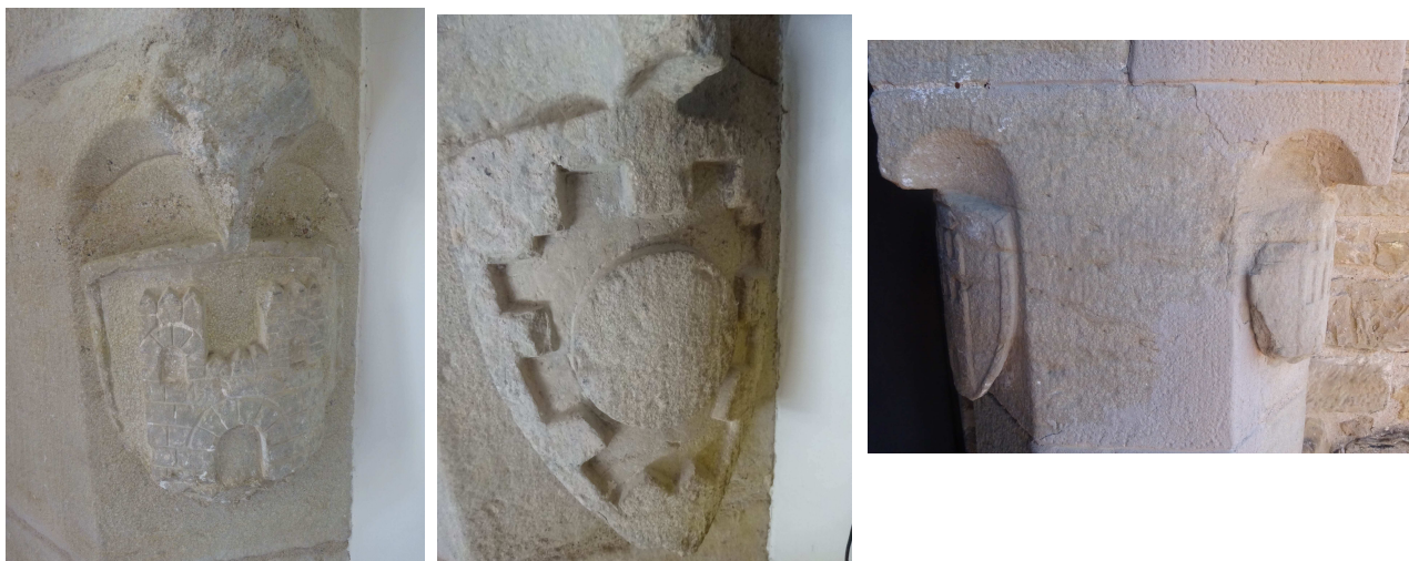
Figura 26: Detalle de dos montantes y un capitel orientales de la segunda planta del monasterio © Araceli Rosillo, 2016.
