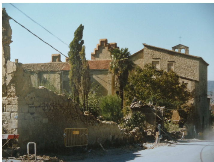
Figura 12: El muro norte del monasterio tras el tornado de 1987 © AASCM.
