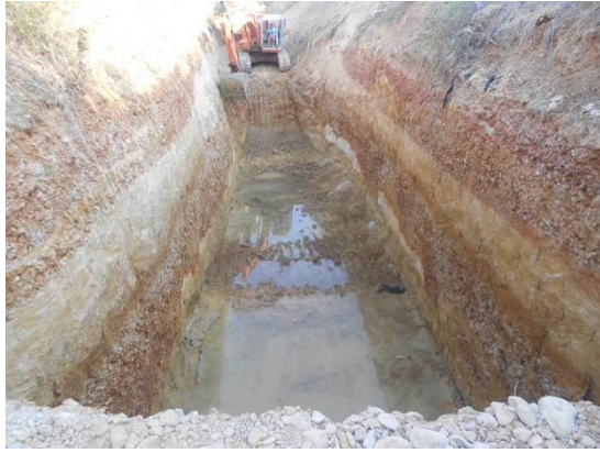
Escavação do leito do rio Seco
