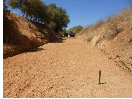
Enchimento das bacias de MAR do rio Seco
