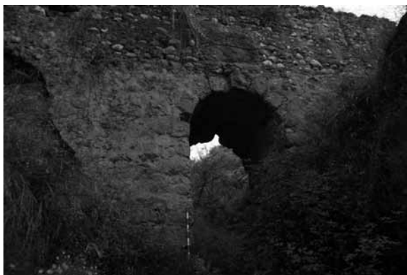
LÁM. 9: Substructio del acueducto con vano central abovedado sobre el barranco de La Umbría del Moral I. Tramo IV.
