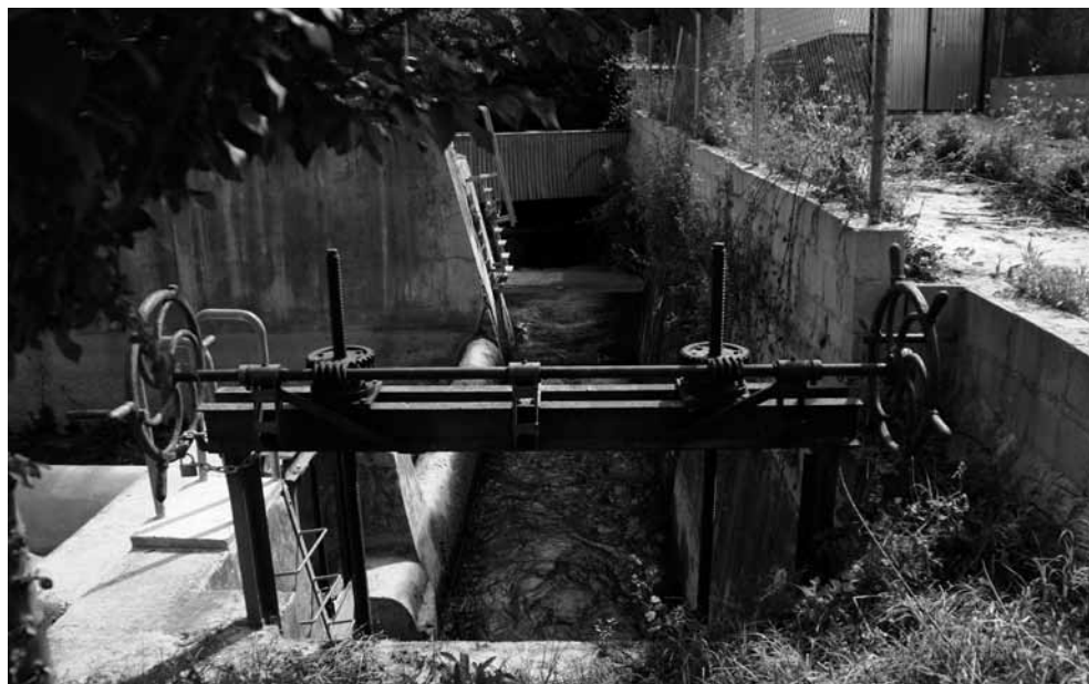
LÁM. 18: Encauzamiento del agua del Nacimiento. Actual Canal de Albolote. Deifontes.
