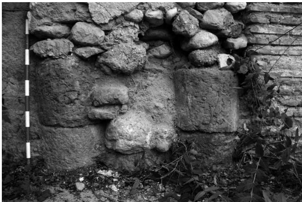
LÁM. 19: Tambores de columnas romanas reutilizadas en una construcción próxima al Nacimiento de Deifontes.
