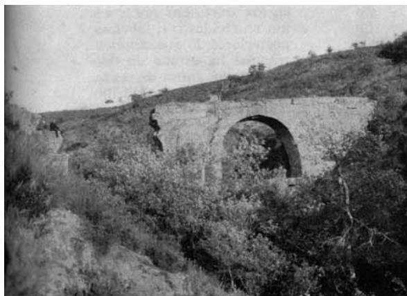
LÁM. 8: Arcuatio del acueducto en el Barranco de los Arcos. Foto: Fernández Casado (1972).
