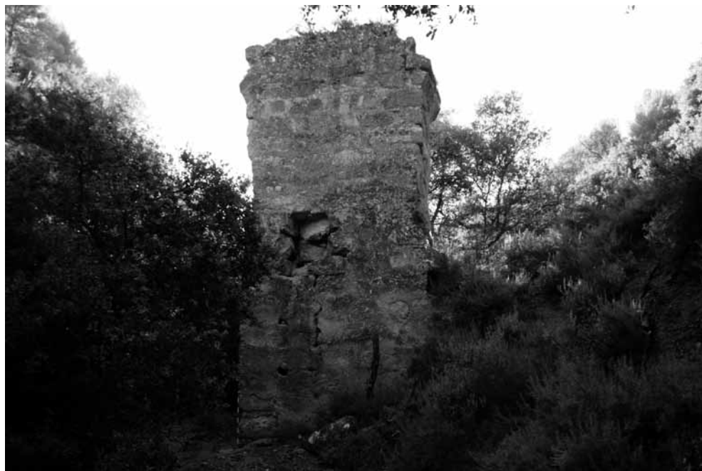
LÁM. 7: Pilar central perteneciente a la arcuatio del acueducto del Barranco de los Arcos.
