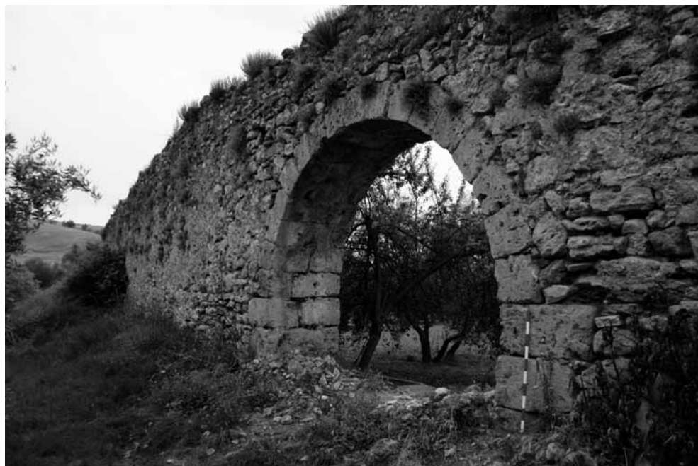
LÁM. 14: Substructio con arco del acueducto de Calicasas. Tramo VII.
