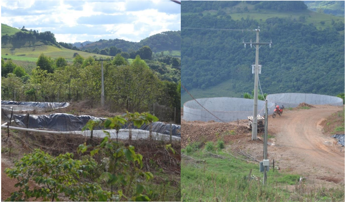
Figura 17 - Esterqueiras sem cobertura, revestidas de manta plástica, e de alvenaria
