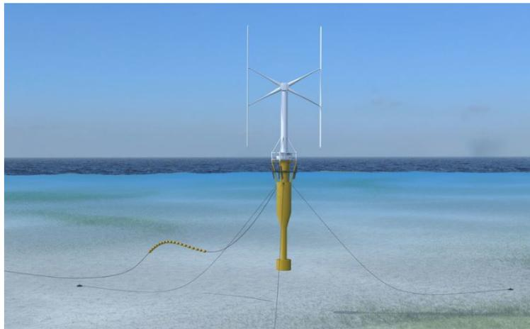
Figura 1.11: Plataforma tipo spar (Fuente:www.kirt-thomsen.com)
