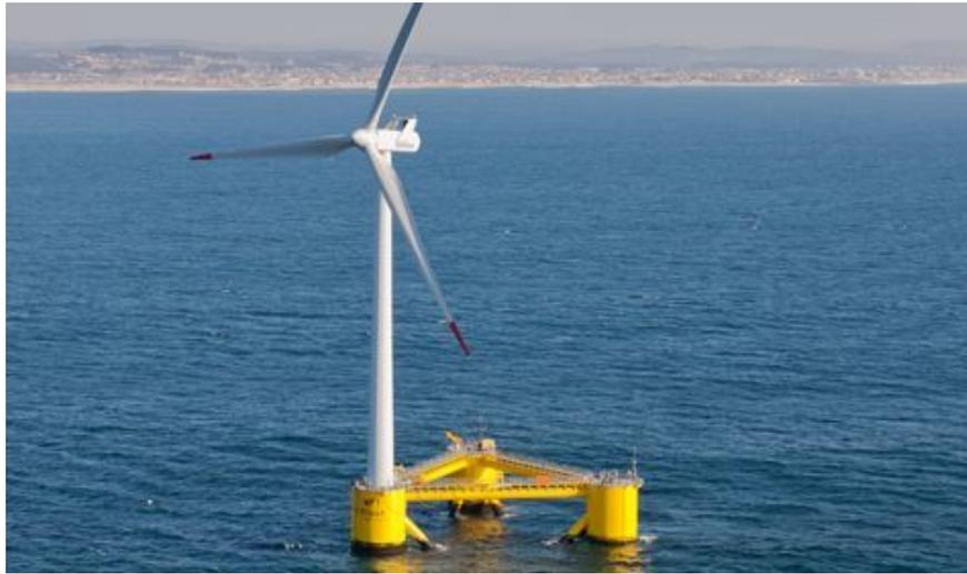
Figura 1.9: Plataforma semisumergible tri-flotador (Fuente:www.erwind.es)
