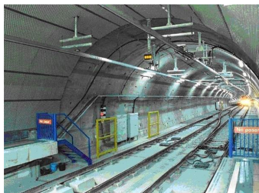
Figura 3.4: Instalación de catenaria rígida
