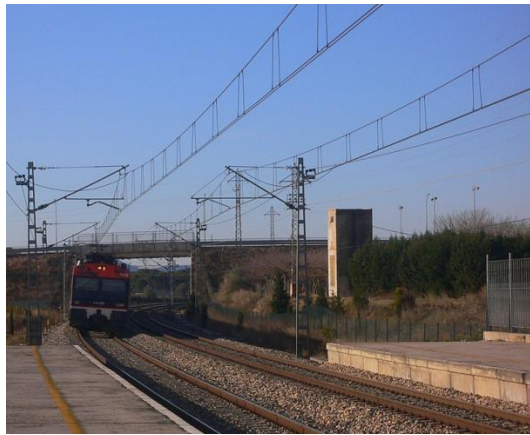
Figura 3.3: Instalación de catenaria flexible
