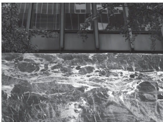
[F5] Ludwig Mies van der Rohe, Edificio Seagram, vista lateral del zócalo del edificio Seagram de Nueva York. Fotografía del autor.
