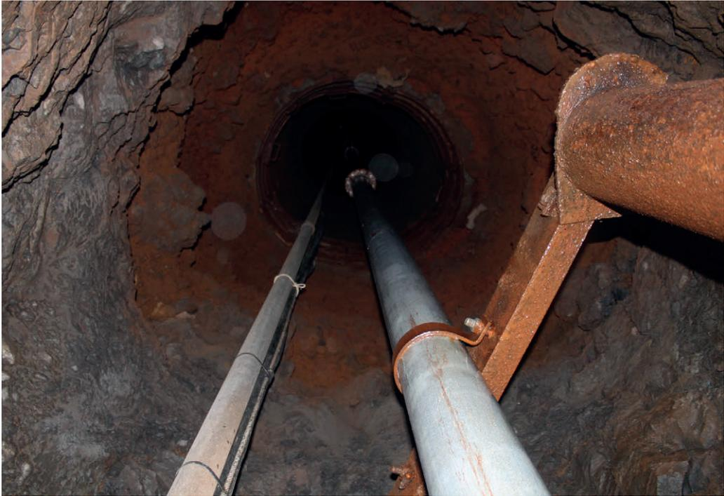
Figura 7.9.- Vista desde el fondo de un pozo canario y sus instalaciones de bombeo de aguas.
