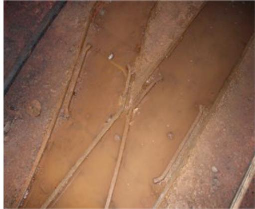
Figura A.11.- Railes en proceso de oxidación al estar "embebidos" en el agua de repisa de la mina.
