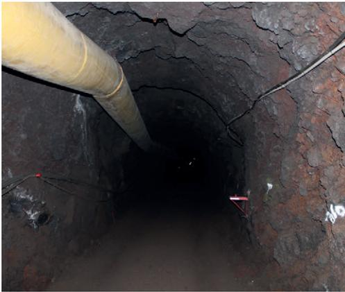
Figura A.14.- Ventilación flexible para adecuar la atmósfera de la mina en el proceso constructivo de la misma.
