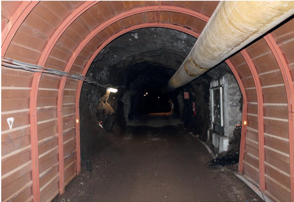
Figura 7.1.- Tubería flexible de ventilación.
