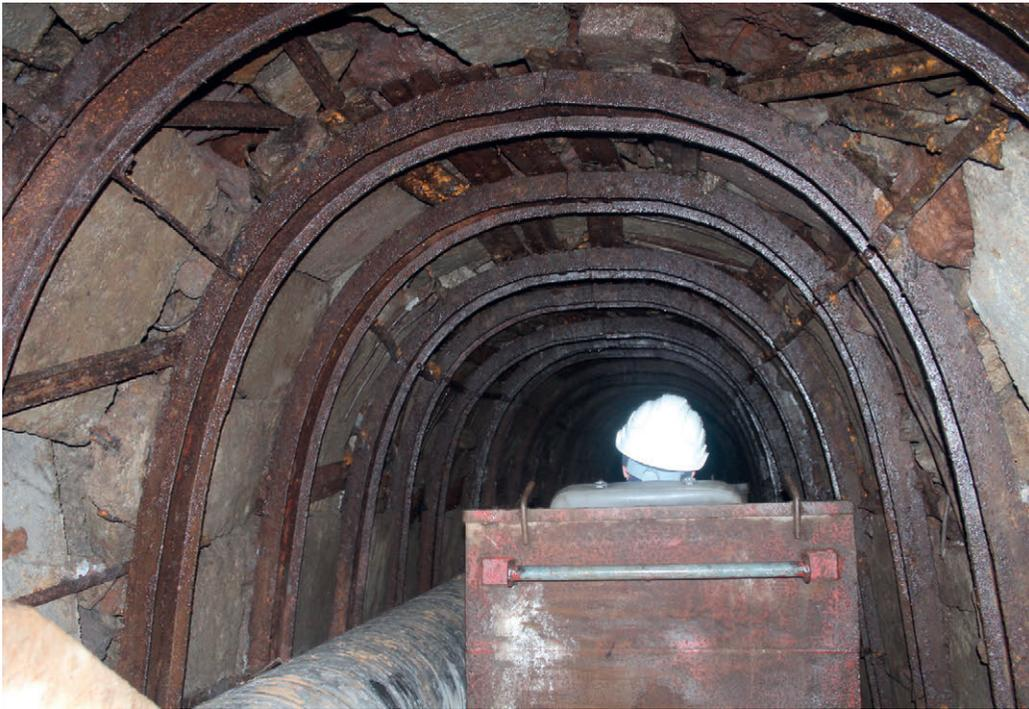
Figura 7.2.- Archetado de la sección de una galería.
