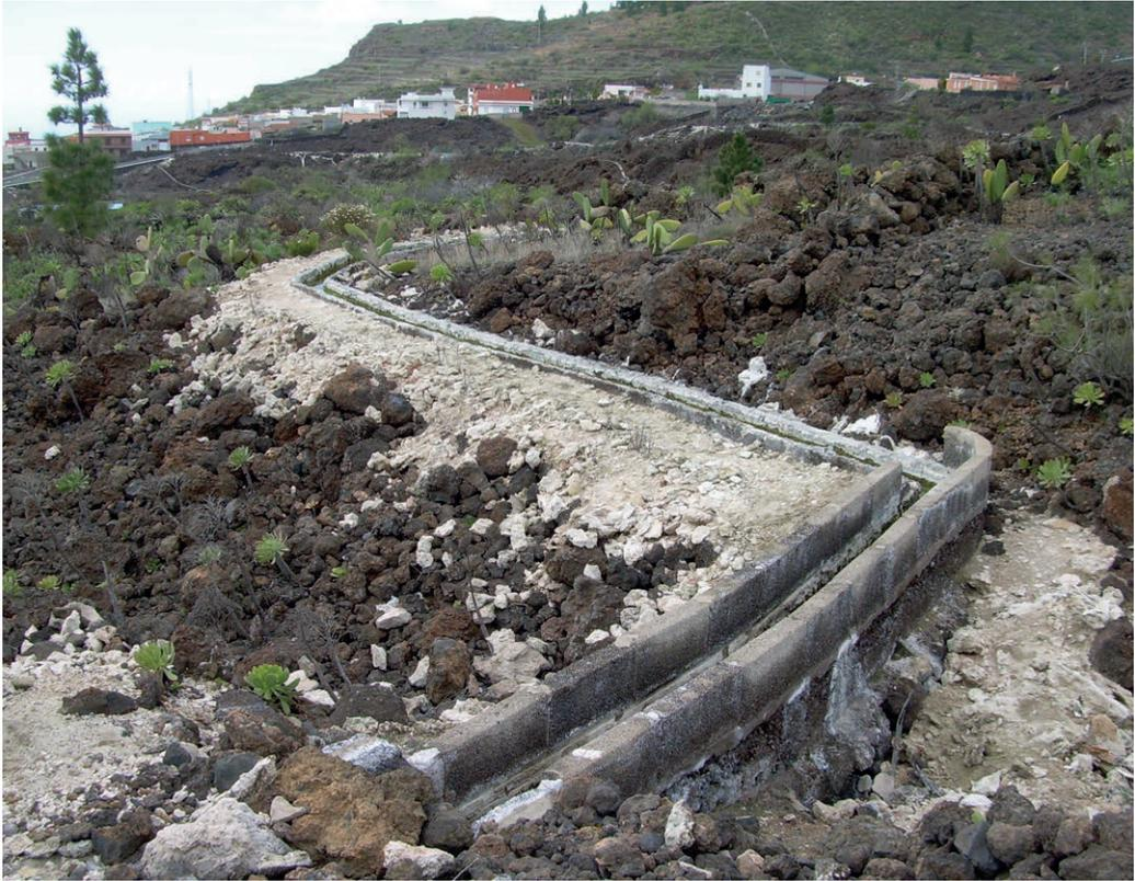
Figura 3.16.- Limpieza de canal debido a la precipitación de carbonatos.
