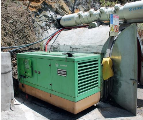
Figura A.6.- Equipo electrógeno para suministro energético de la obra.
