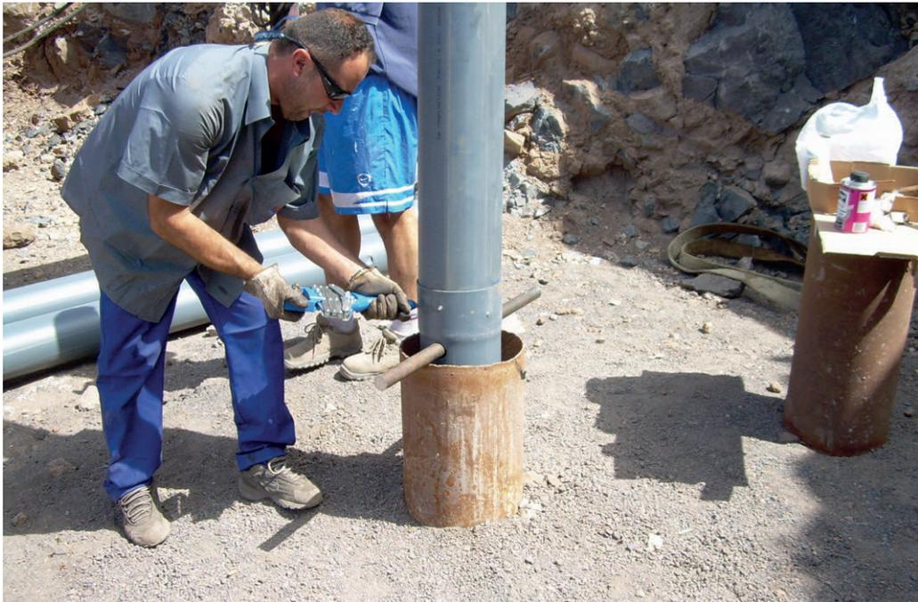
Figura 4.6.- Entubado de un sondeo.
