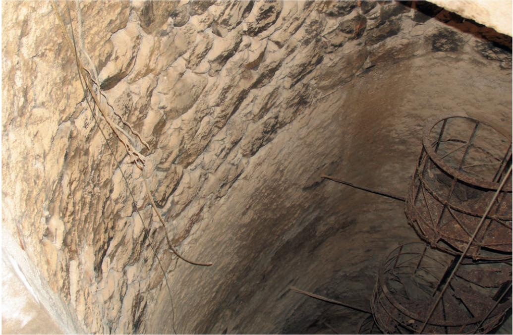
Figura 4.5.- Caña del pozo revestida.
