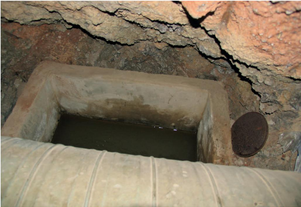
Figura A.2.- Tanquilla para aforo y control de caudales alumbrados.
