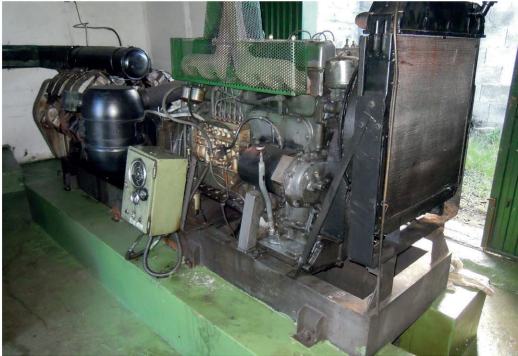
Figura 7.7.- Motor generador de energía para la instalación.
