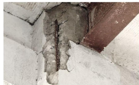
2.5. Unión de viga metálica con pilar de hormigón
