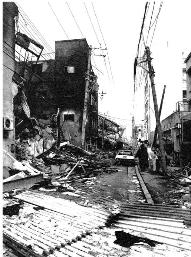
2.21. Imagen tras el terremoto de Kobe
