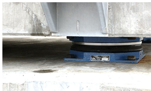
3.3. Sistema de péndulo de fricción
