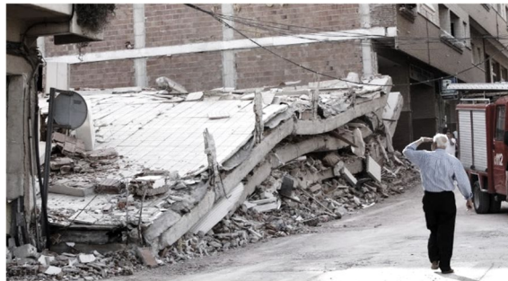
0.12. Terremoto de Lorca, España, 2011
