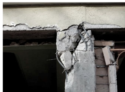
2.16. Unión viga - pilar
