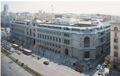
Fig 17: Banco de España. Madrid. Ampliación de Rafael Moneo. Fuente: revista Arquitectura Viva ( www2.arquitecturaviva.com )
