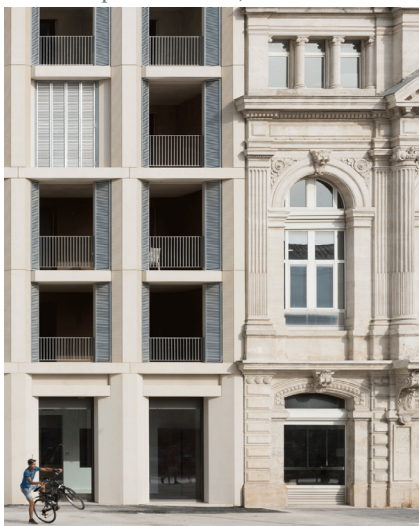
Fig 21: Detalle huecos bloque de apartamentos. Nimes. Foster & Partners. 2011-2015
