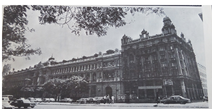
Fig 33: Esquina objeto del concurso antes de la demolición del antiguo edificio.
