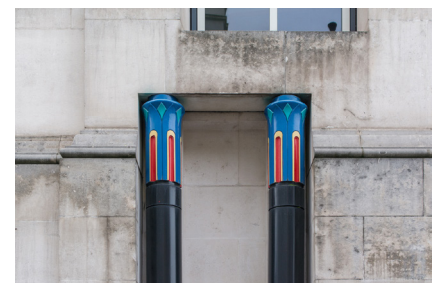
Fig 15: Detalle columnas del ala Sainsbury de la Galería Nacional de Londres. Fuente: Arch Daily ( www.archdaily.com )
