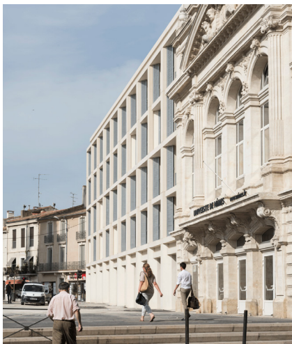
Fig 20: Bloque de apartamentos La Porte Romaine . Nimes. Foster & Partners. 2011-2015
