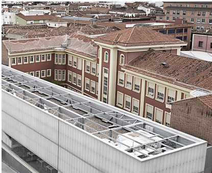
Fig 72: Vista del único edificio que se conserva de la manzana. Fuente: Plataforma Arquitectura
