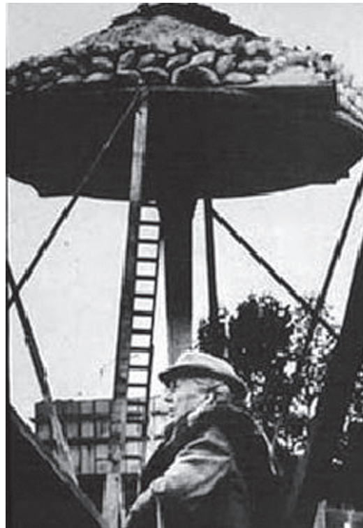
Figura 3 Fotografía de la prueba de carga de las columnas dendriformes del edificio para la compañía S.C. Johnson & Son (Martín 2011, 45)
