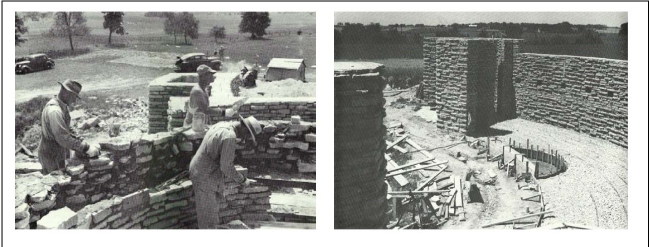
FIGURE 6 Images de la construction du logement. Paroi de pierre calcaire composée de deux feuilles attachées avec des clés métalliques. Paroi complétée et construction de la dalle de rez-de-chaussée avec des tuyauteries enfoncées dans cette dernière pour le système de chauffage «Gravity Heat». (7)
