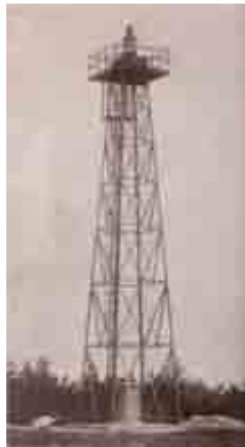
Aerofaro de Hellenendoorn. Torre celosía de acero de 17 m de alto. 1930
