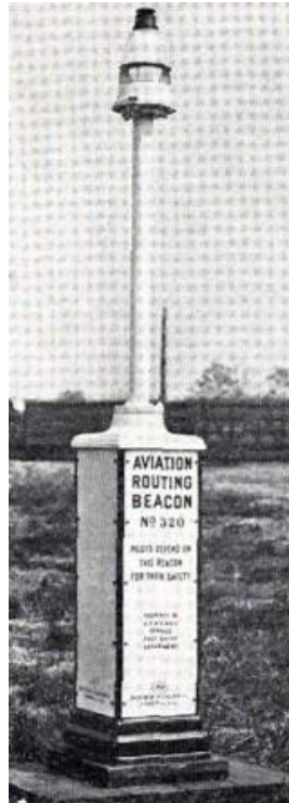
a) Aerogenerador de Aerofaro; b) Luz complementaria de aerovía. Aircraft Year Book - Ben Ashlock Steve Wolff collection.
