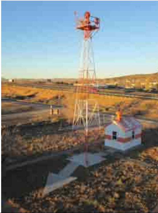
Aerofaro del aeropuerto Grants-Milan perfectamente conservado por Cibola County Historical Society - Aviation Heritage Museum Tipo de instalación de aerofaro de 1931.
