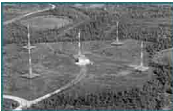
Estación de radionavegación LFR en Northway Alaska. Fotografía National Archives. Década 1930.
