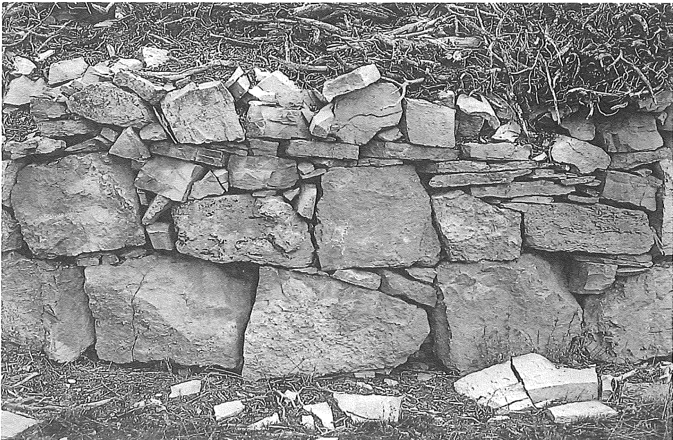
Anchuelo del Camino (Guadalajara). Paridera. Detalle de cimentación.
