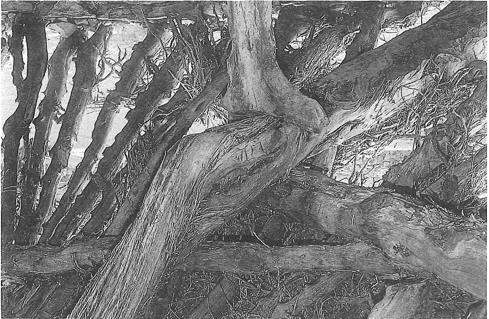
Anchuelo del Camino (Guadalajara). Paridera. Detalle de nudos estructurales.
