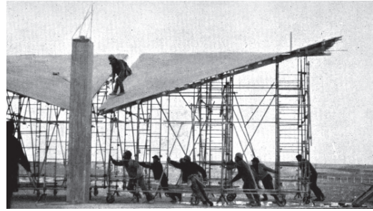
Figura 2 Encofrado y cimbra rodante (Ruiz-Castillo 1966: 31)
