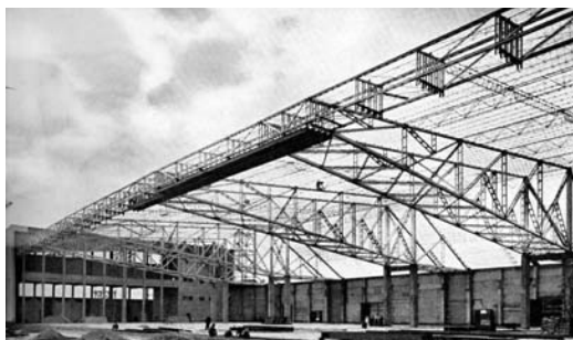
Figura 7 Hangar con cerchas en voladizo, Barajas (Cuidós 1960)
