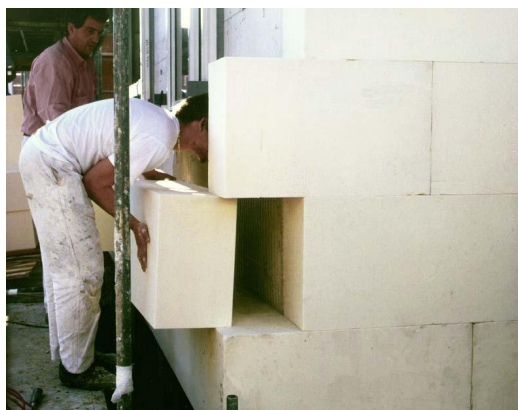
Fig. 3. Ejemplo de sistema constructivo de gran espesor mediante aplicación de nuevos materiales.
