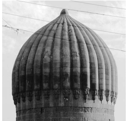
Figura 1 Cúpula sobre un mausoleo de la necrópolis Sur del Cairo adornada exteriormente con nervios semicilíndricos radiales, construida en piedra con sillares en voladizo de lechos horizontales (foto del autor 2013)
