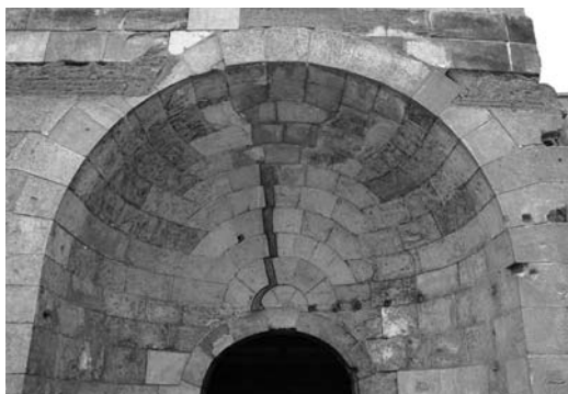
Figura 6 Macla de dos aparejos en la misma superficie esférica: dovelas girando alrededor del eje vertical y un segundo sistema de dovelas girando alrededor del eje horizontal. Bajo la cúpula un arco en torre cavada. Bab Zويلة. 1092 (foto del autor 2013)
