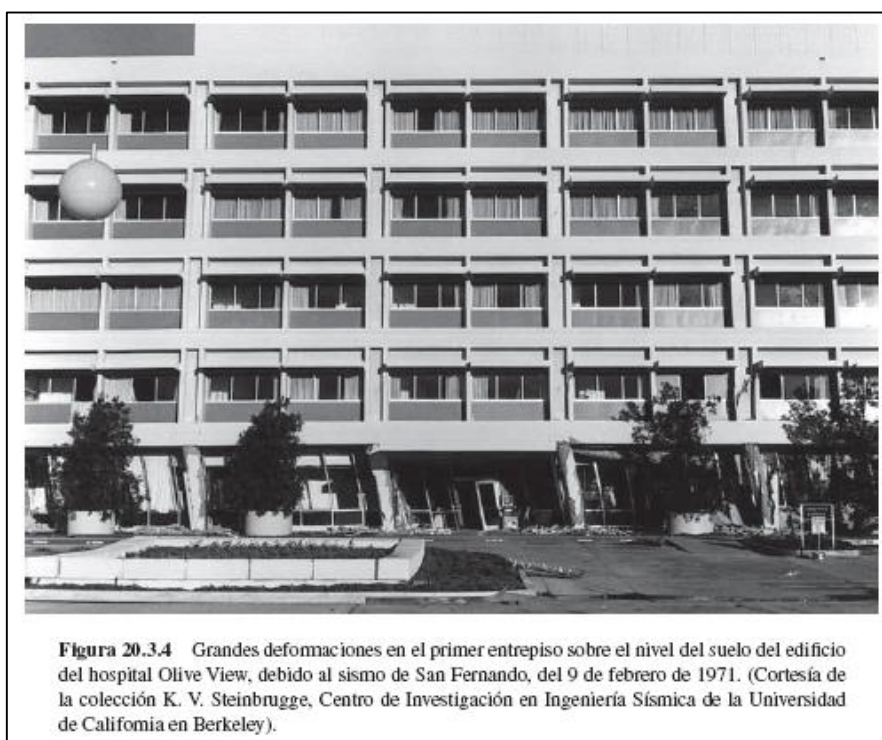
Figura 2.10. Formación de planta débil ante terremoto
