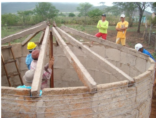
Figura 9. Pared y vigas de cubierta.
