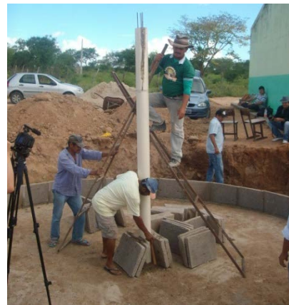
Figura 10. Construcción del pilar.
