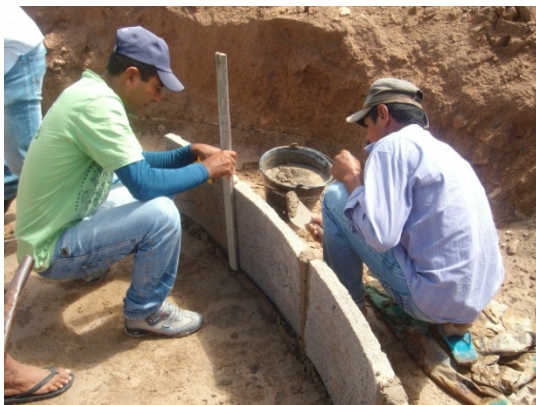
Figura 7. Construcción de pared.
