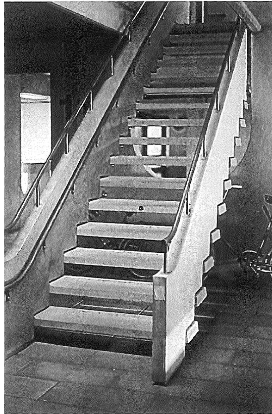
Figura 2.10.- Típico elemento funcional prefabricado, escalera de tramo recto con peldaños individuales, suministrado por una empresa productora de elementos de catálogo sueca. (Foto J. Salas).
