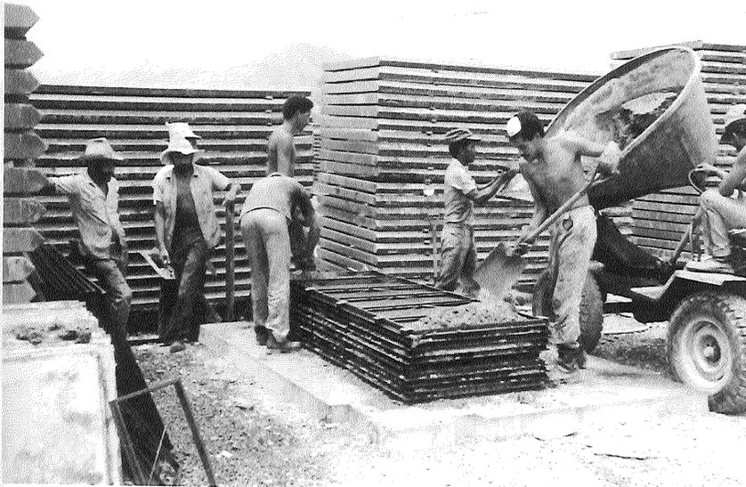
Figura 5.15.- Hay que evitar la disgregación de la masa en el vertido del hormigón fresco, pero no necesariamente con procedimientos sofisticados sino con medidas lógicas que deben ser rigurosamente respetadas. (Foto J. Salas).
