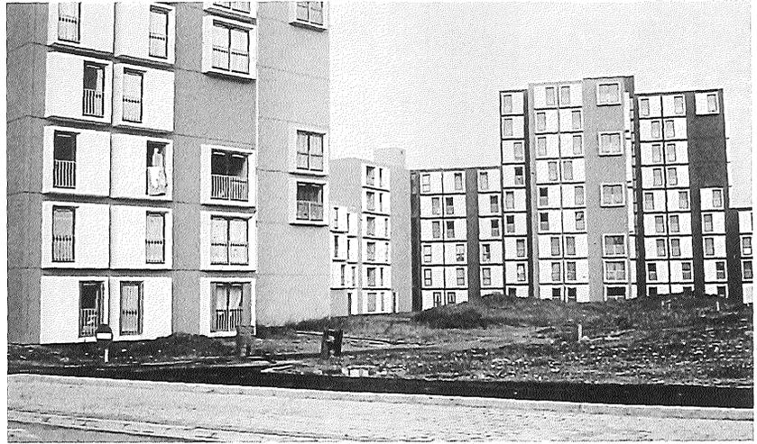
Figura 2.8.- Conjunto de 300 viviendas prefabricadas, segunda generación, en la ciudad nueva de Lille-Este en Francia 1974. Aparecen cambios volumétricos, flexibilidad de distribuciones, color, elementos singulares... (Foto J. Salas).
