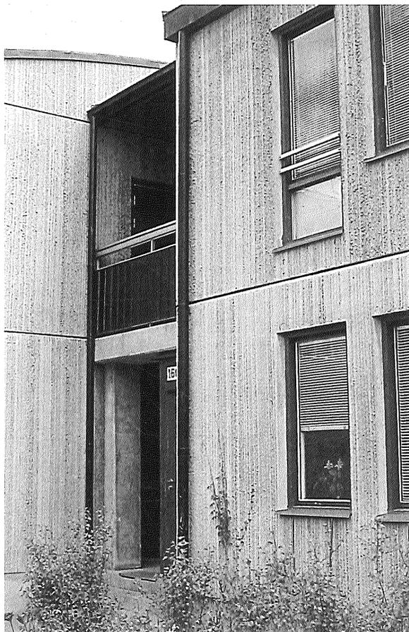
Figura 2.32.- Paneles de fachada tratados manualmente antes del endurecimiento de la cara externa y que mediante pequeñas canalizaciones permiten facilitar el descenso "ordenado" del agua de lluvia. (Foto J. Salas)
