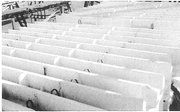
Figura 6.12.- Apilado de grandes elementos de hormigón en forma de biblioteca vertical en la que fué planta de producción «KPD» en Villa Alemana, Chile, 1973. (Foto J.Salas).
