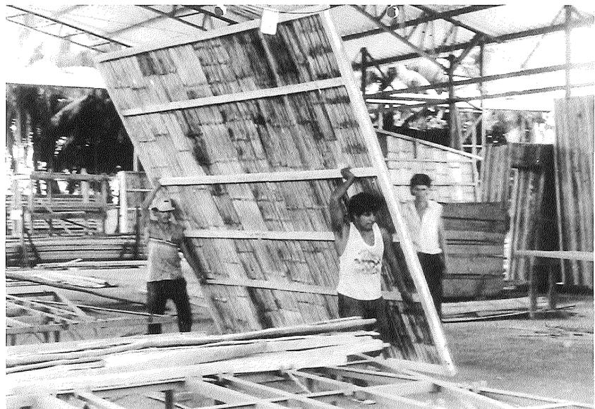
Figura 5.45.- Momento de la construcción de viviendas con guadua, su utilización como: pilares, jácenas, viguetas y elementos de cerramiento. (Foto J.H. Arcila).
