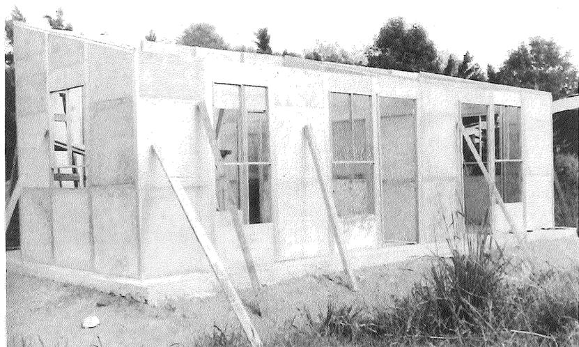
Figura 5.8.- Los paneles ligeros de hormigón presentan muy diversas variantes en prácticamente todos los países latinoamericanos. La imagen muestra el proceso de ejecución de una vivienda del sistema Servivienda de Colombia, que acumula una dilatadísima experiencia en este tipo de construcción para los más pobres. (Foto J. Salas).
