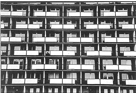
Figura 2.3.- Típica imagen de fachada de bloques de apartamentos prefabricados realizados con la obsesión de minimizar el número de elementos distintos por vivienda. (Foto J. Salas).
