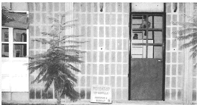
Figura 5.7.- Vivienda semilla del CEVE a base de paneles cerámicos del sistema BENO. (Foto J. Salas).
