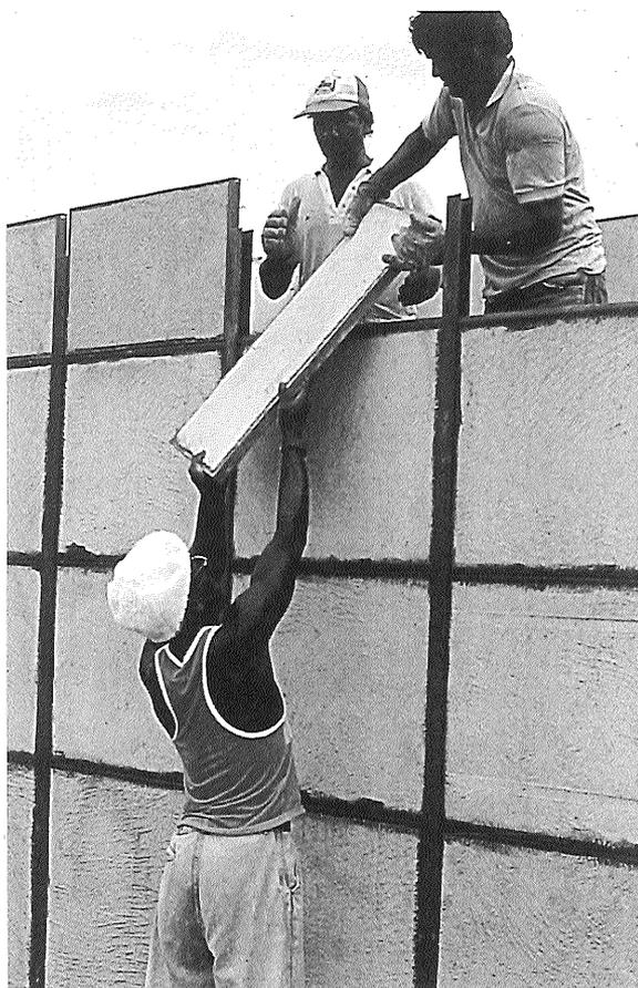
Figura 2.33.- Producción, manipulación y montaje manual de elementos, una meta lógica de la industrialización de la vivienda de una planta en Latinoamérica. En la figura, el montaje de elementos Sancocho de Venezuela. (Foto J. Salas).
