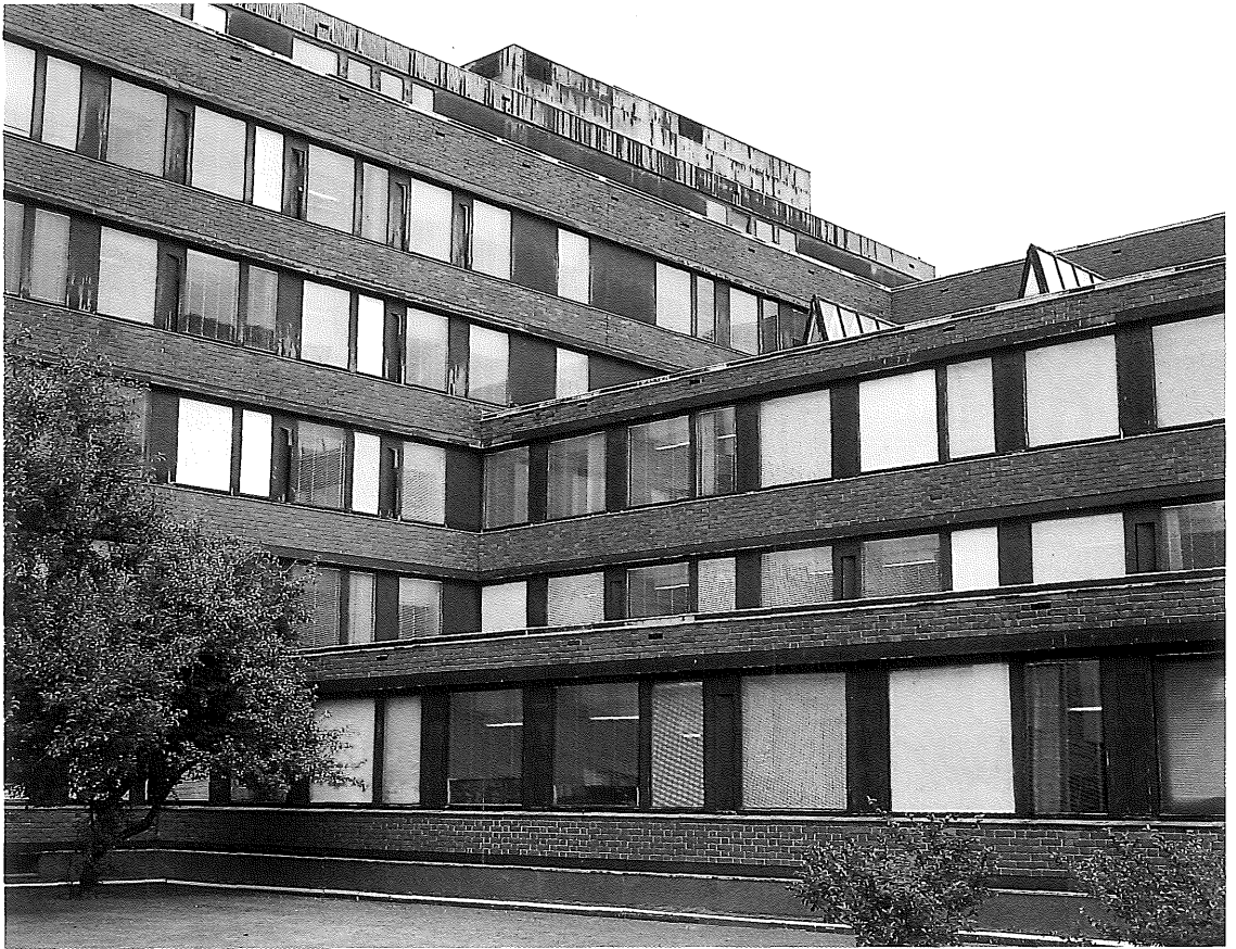
Instituto Finlandés de Pensiones (Helsinki, 1948-1956). Detalle del patio abierto trasero, con la utilización de la fachada de bandas de ladrillo para cualquiera que sea el volumen, de A. Aalto
