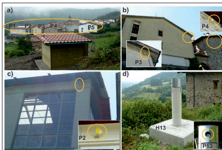
Figura 13. a) Caseta de control (en primer plano) y vista de las fachadas sobre las que están alojados los prismas de control (localización en planta en la figura 12 para). b) y c) Detalle de los prismas P3, P4 y P5. D) Prisma P13 alojado dentro del hito (o vértice) H13.
