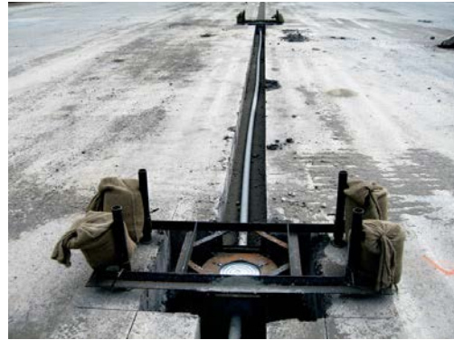
Instalación de tubos y bases de luces empotradas aeronáuticas.
