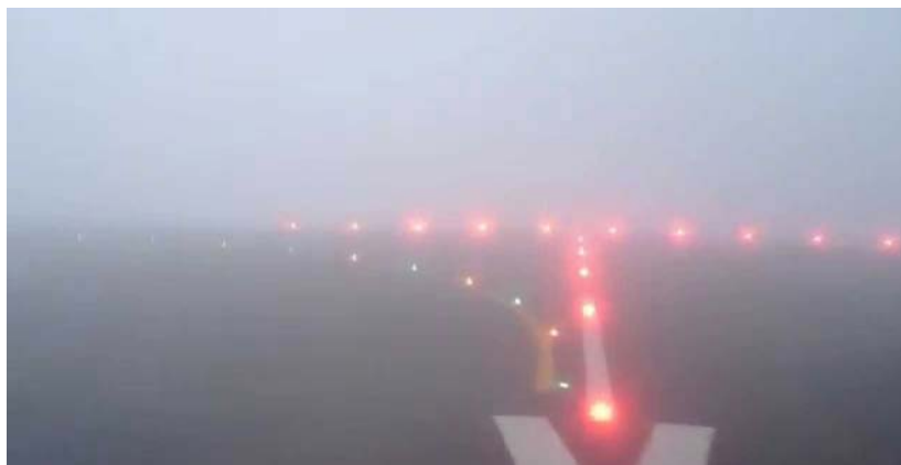
Luces de pista de vuelo y calle de rodaje en una situación con niebla.
