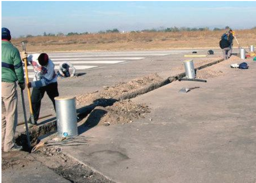
Instalación de tubos y bases de luces empotradas aeronáuticas.
