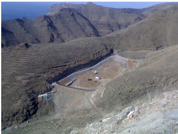
Figura 1.6: Ampliación del vertedero de La Gomera.
