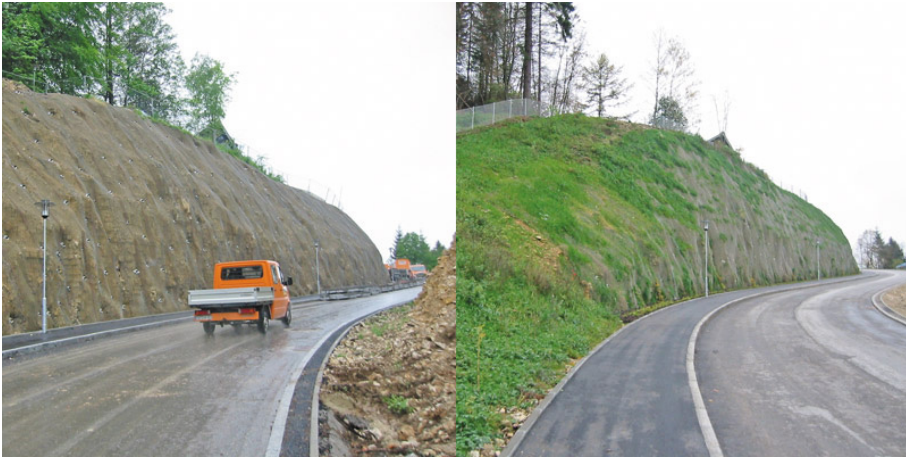
Figura 8.4: Estabilización de taludes mediante revegetación (Fuente: www.geobrugg.com ).
