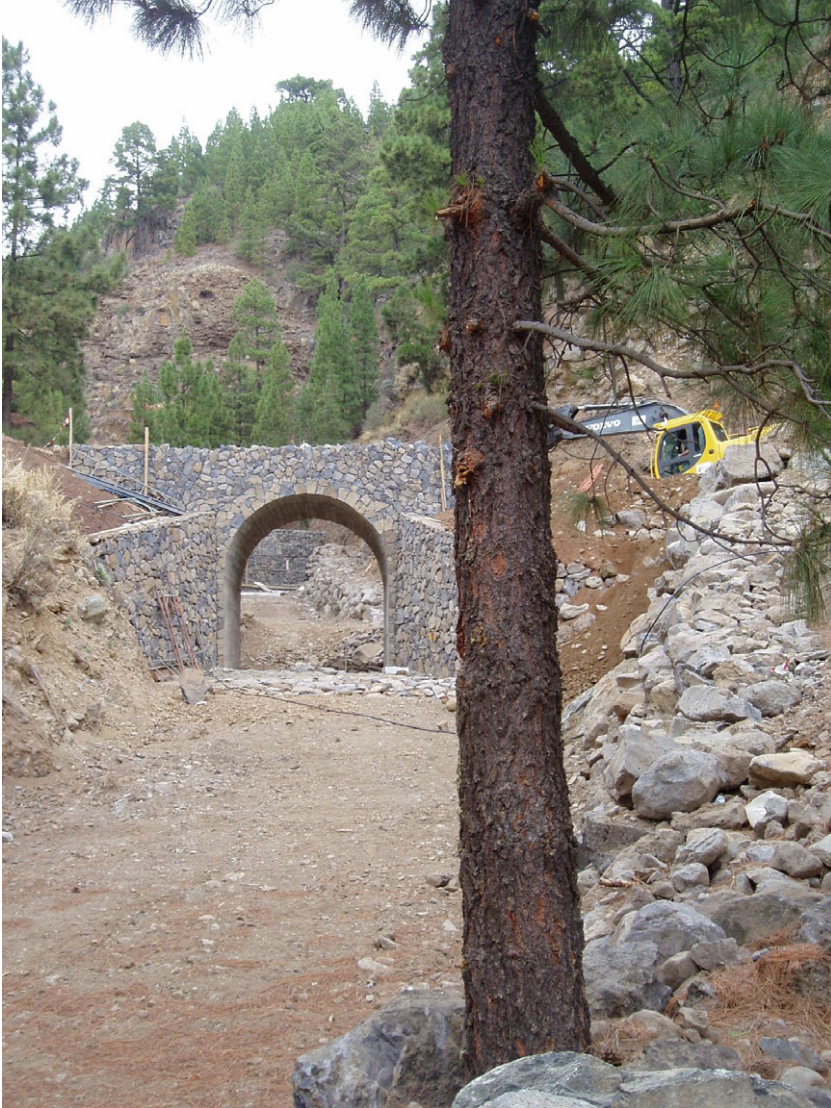
Figura 5.5: Vista parcial del pontón, tras actuación.
