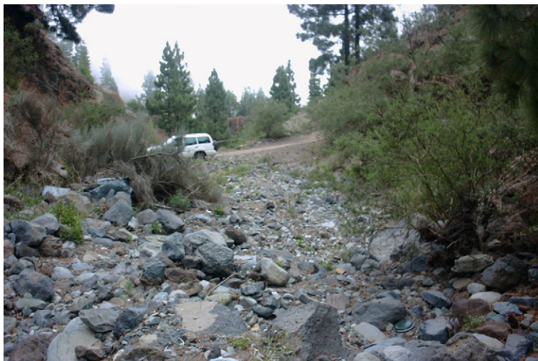
Figura 5.1: Cauce del barranco aguas arriba del pontón.
