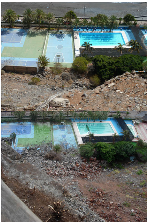
Figura 15.2: Imagen del deslizamiento en el acantilado del Parador de Turismo de La Gomera.
