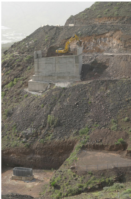
Figura 5.1: Construcción de un viaducto en nueva carretera.
