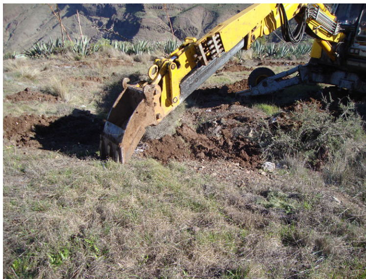
Imagen 3: Realización de banqueta con la retroaraña
