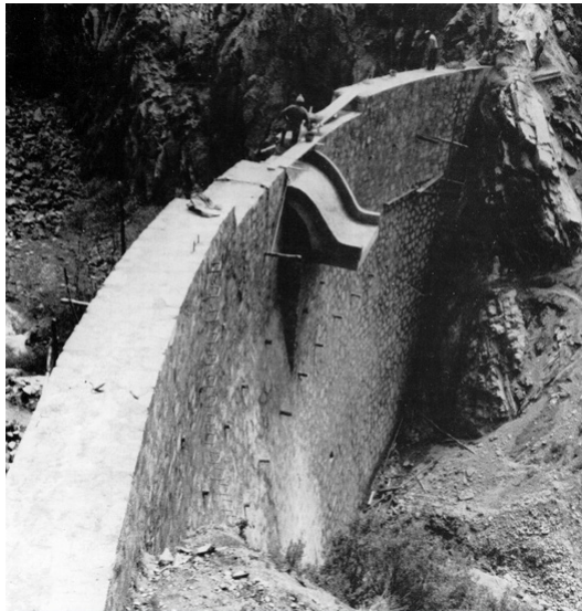
Figura 11.28: Dique en arco con trampolín adosado en el vertedero central, para alejar la lámina de desagüe del pie de la estructura (Foto: memoria del ICONA, 1979; Fuente: Fototeca forestal española, DGB-INIA).
