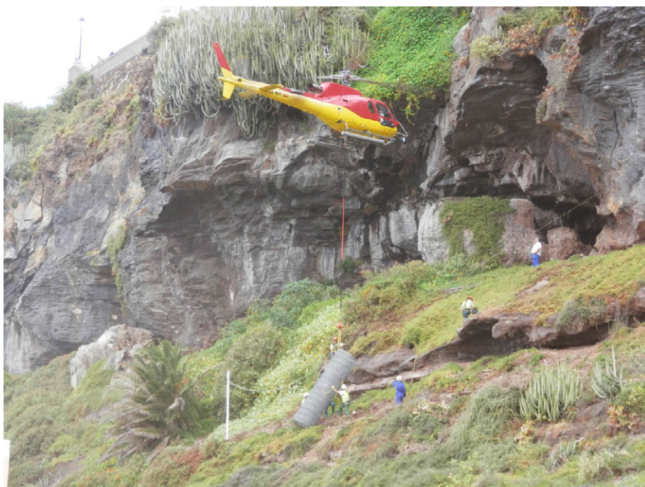
Figura 15.4: Colocación de la malla mediante helicóptero.
