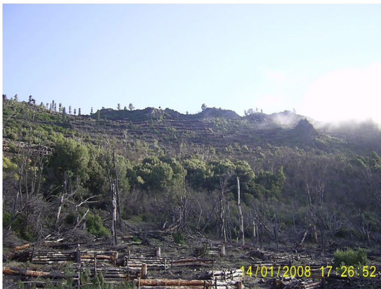
Figura 3.7: Disposición de las empalizadas 9 meses después de su construcción. Apréciase el cordón de monteverde central, con las líneas de empalizadas en la zona superior, y las dispuestas al tresbolillo en la inferior.
