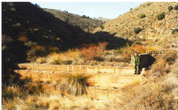
Figura 11.16: Dique de mampostería gavionada enlucida de mortero, construido en 1956 en el barranco de Bijuesca o de Carrabijuesca (Torrijo de la Cañada, Zaragoza). Está completamente colmatado de sedimentos, consolidados por vegetación espontánea.
