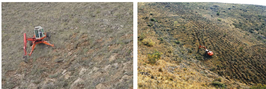
Figura 11.8: Preparación de terreno para repoblación forestal mediante ahoyado mecanizado. A la izquierda: trabajo de una retroaraña en una pendiente del 50%. A la derecha: vista de una ladera ahoyada con retroexcavadora sobre orugas; se aprecia su muy bajo impacto paisajístico (Fotos: I. Pérez-Soba).
