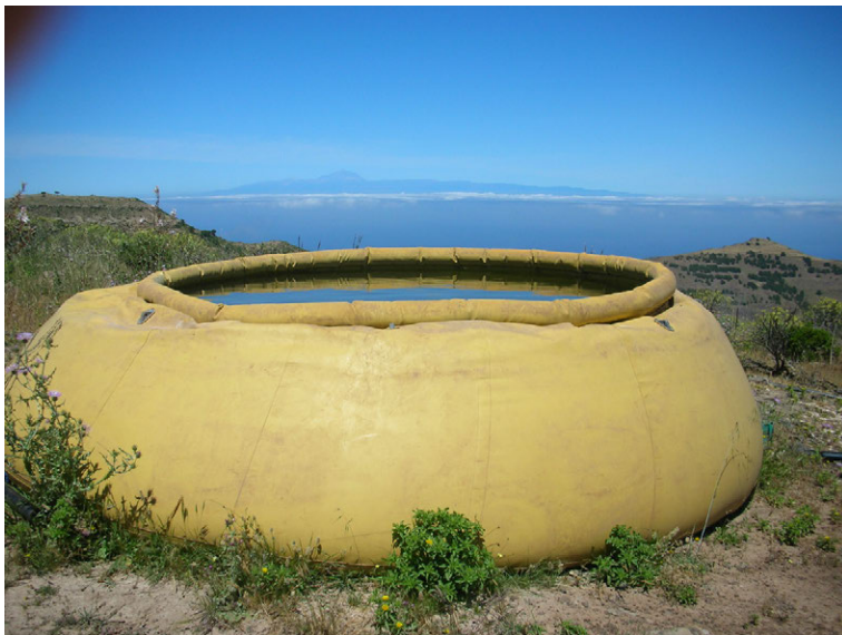
Imagen 18: Depósito flexible de 10.000 litros de capacidad en la Finca de Tirma. 2009-2010.
