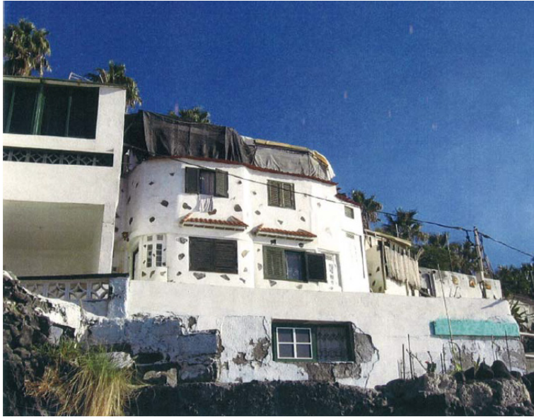
Figura 6.3: Fachadas de viviendas.
