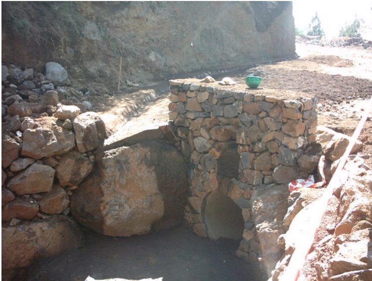
Figura 5.10:Paso de agua en el barranco.
