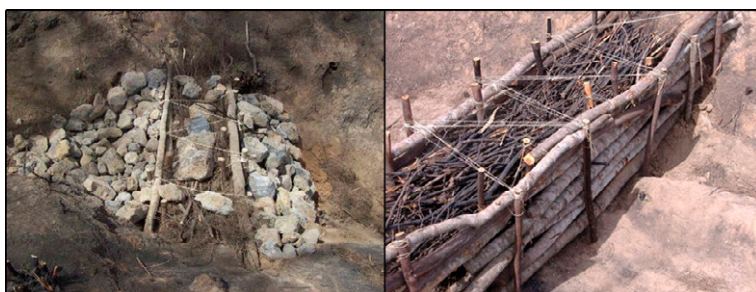
Figura 12.9: Dique mixto de mampostería y biomasa (izquierda) y detalle de la matriz interior rellena de ramas procedentes del desbroce de la vegetación afectada por el fuego (derecha).
