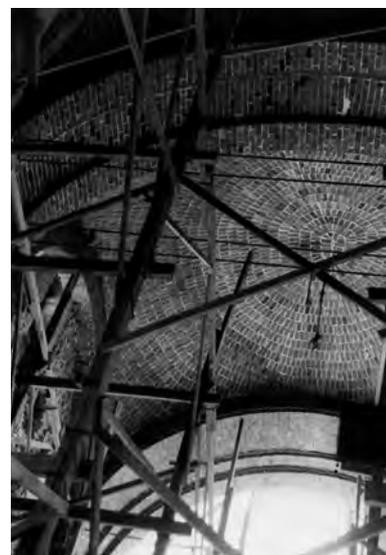
**fig. 8.** Bóveda vaída de la iglesia de la Asunción en Manzanares: esquema, con indicación del aparejo en espiral, para realizarse sin cimbra; detalle de la construcción.
