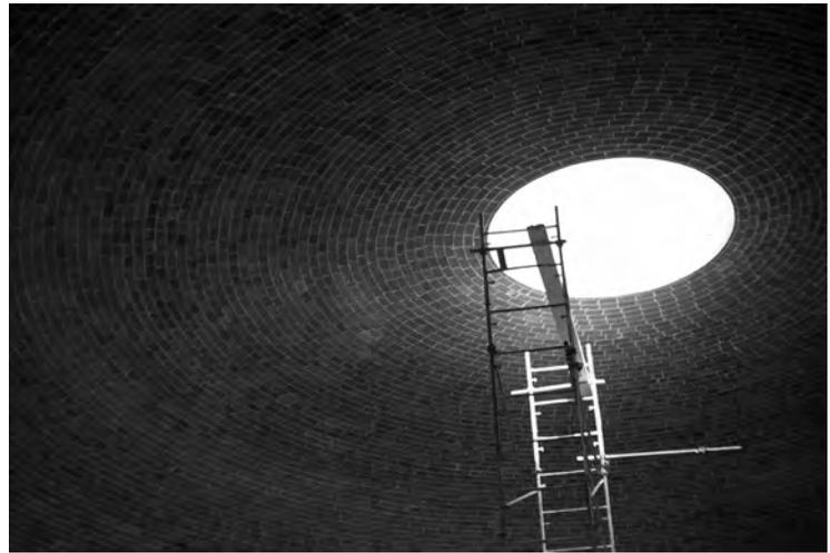
fig. 9. Parroquia de Santa María Madre de la Iglesia (Madrid): proceso constructivo de la cúpula tabicada, mediante guía giratoria, dejando el intradós visto (inf. izda: el arquitecto con técnicos del Instituto Torroja) [col. part. J.M.].
