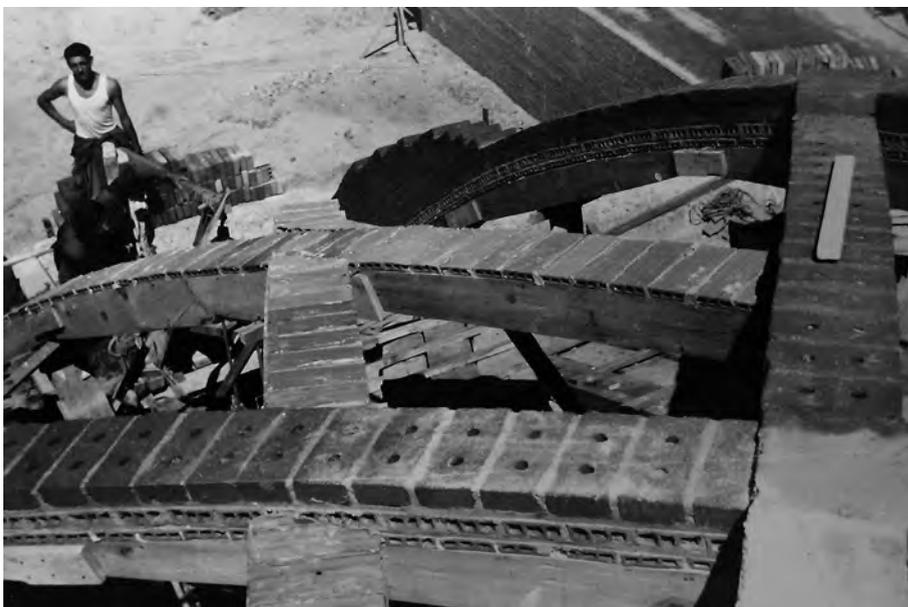
fig. 12. Proceso constructivo de los arcos cruzados de ladrillo: bóveda de la iglesia de San Agustín y de la capilla de la Universidad Laboral de Gijón.
