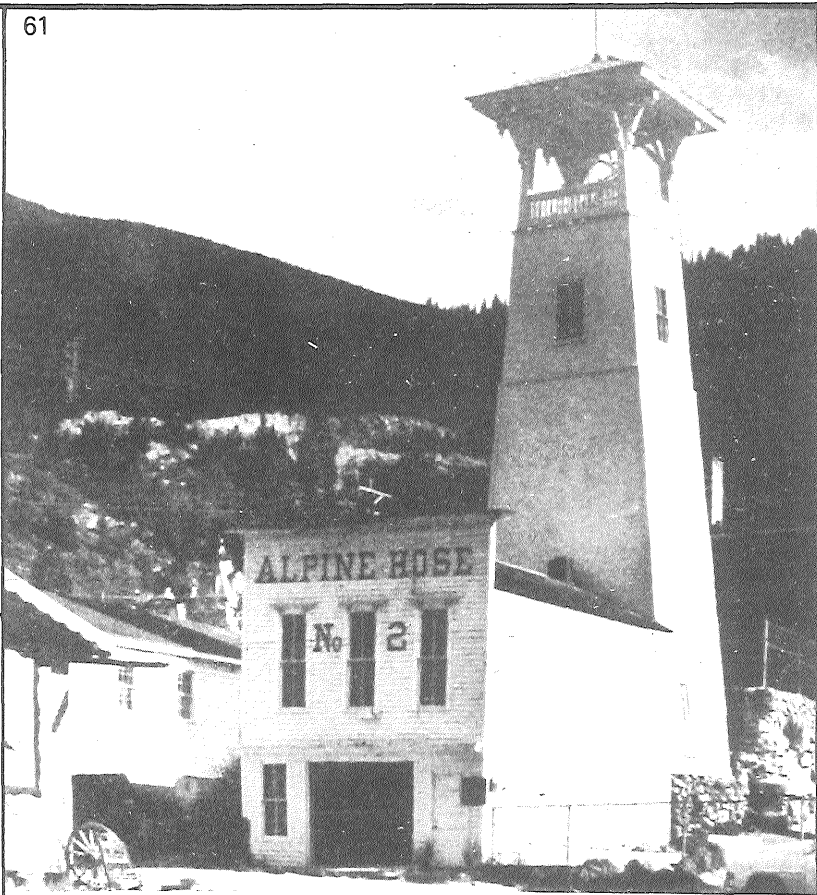
Fig. 61 Dos ejemplos de finales del siglo XIX del estilo de falsa fachada de la arquitectura de las estaciones de bomberos, existentes en Georgetown, Colorado: la estación alpina número 2 (arriba) y la estación Old Missouri (abajo).
