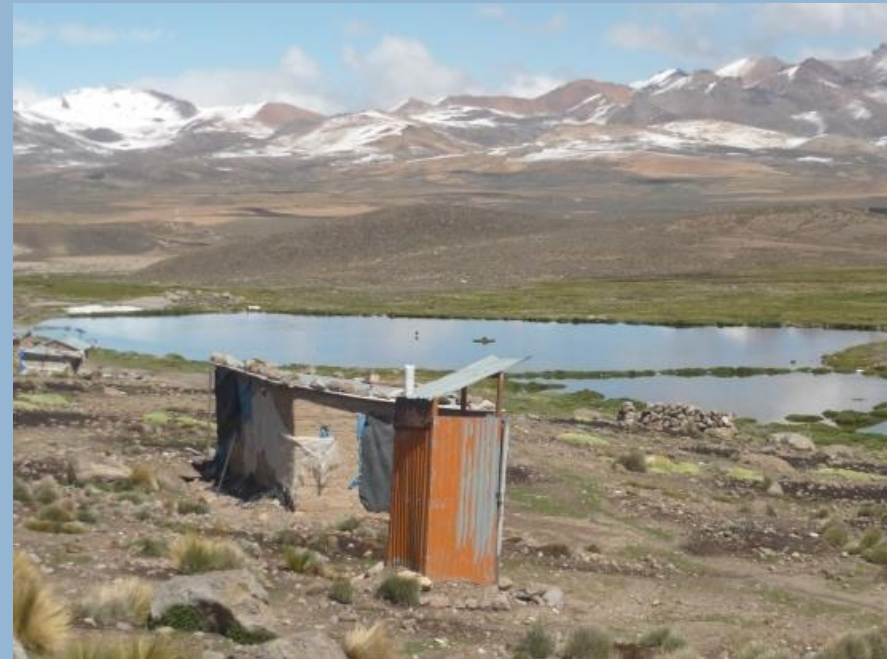
Letrina pública del centro poblado de Jacopunco, Perú, no cuentan con instalaciones de agua potable, usan el agua de la laguna. Fuente: www.regiontacna.gob.pe/.../letrina.jpg
