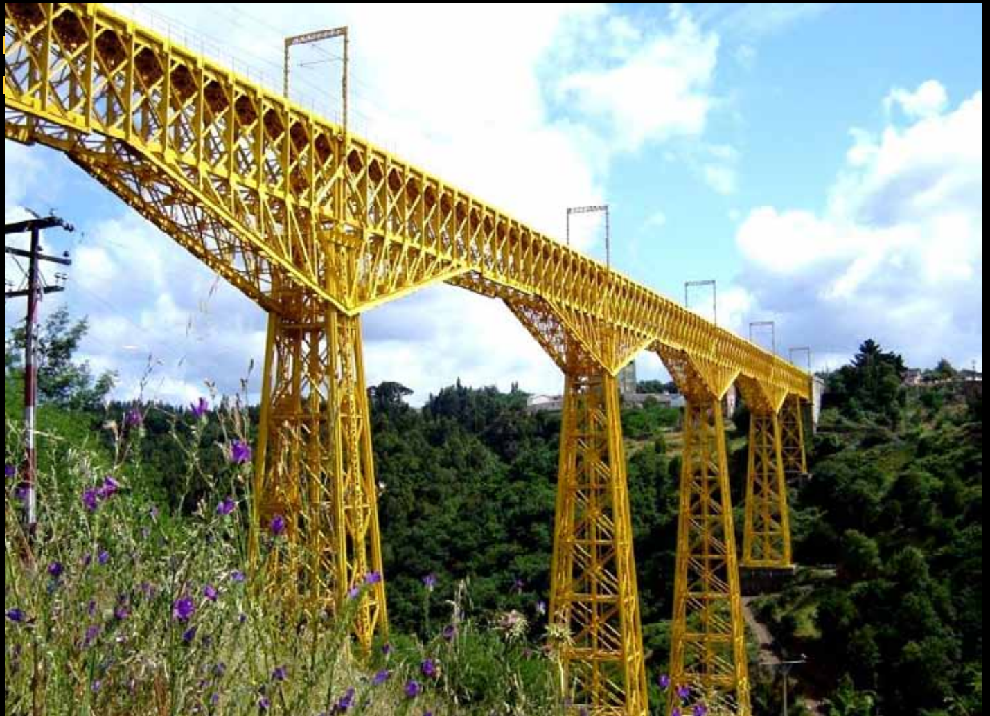
Ponte fiume Malleco
