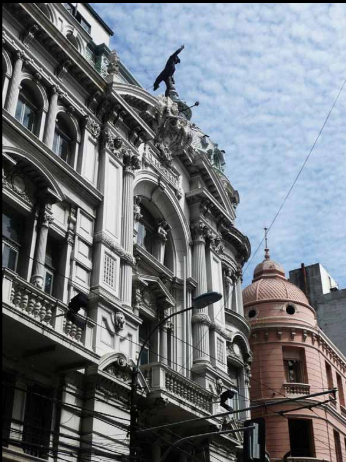
Edificio Giornale El Mercurio di Valparaíso
