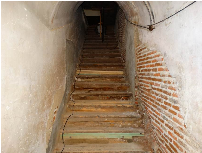
Foto 3. Peldañeado de la escalera.
