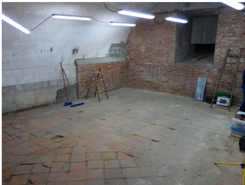
Foto 12. Pavimento, zona sureste. La alineación del pavimento cambia en la mitad sur.
