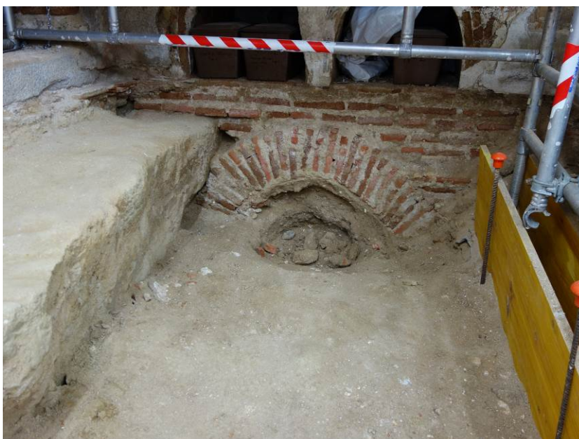
Foto 15. Arco de cimentación del columbario. Lado izquierdo, junto a la escalera.
