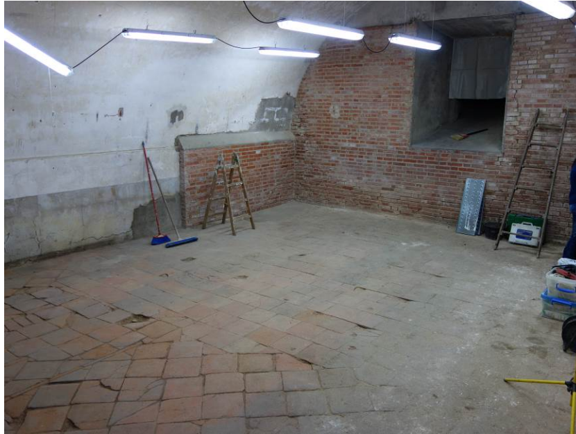
Foto 8. Muro sur de la cripta, y arranque del lado este de la bóveda. Se aprecia el refuerzo de ambos con ladrillo industrial, en una reparación de 1980.
