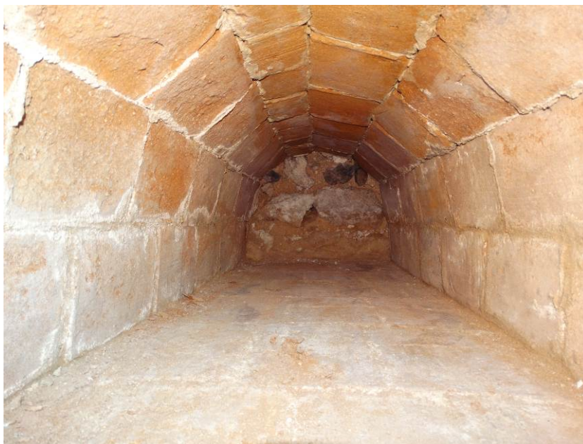
Foto 14. Interior del nichos nº7 (primera planta, junto al arcosolio).
