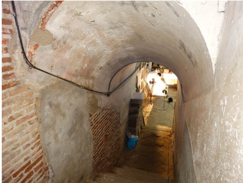
Foto 2. Bóveda de la escalera de bajada a la cripta. Es cilíndrica, de medio cañón. E inclinada con la pendiente de la escalera.
