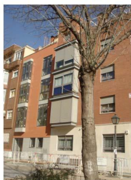
Fig. 1 El mirador tradicional de la foto de la derecha está ahora transformado en un elemento de cristal que no tiene el muro de cerramiento por detrás y que modifica negativamente el flujo de calor en determinadas fachadas madrileñas. El Plan General de 1985 incentivaba estos miradores ya que no computaban como edificabilidad. Fuente: Archivo del autor.
