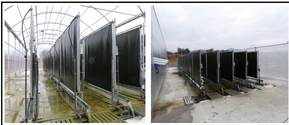
Figura 6. Planta piloto para el estudio de la producción de microalgas por el sistema PBRL en las instalaciones de Valpuren del término de Polán (Toledo) que utiliza como fuente de CO 2 los gases de escape de los motores que queman el biogás producido en la planta y como medio de cultivo el efluente procede del secado de los lodos que se obtienen en la digestión anaerobia de los purines. A la izquierda se presenta una vista de la parte de la instalación protegida con cubierta plástica de polietileno (5 líneas de 10 paneles cada una) y a la derecha la parte de instalación al aire libre (otras 5 líneas de 10 paneles cada una).
